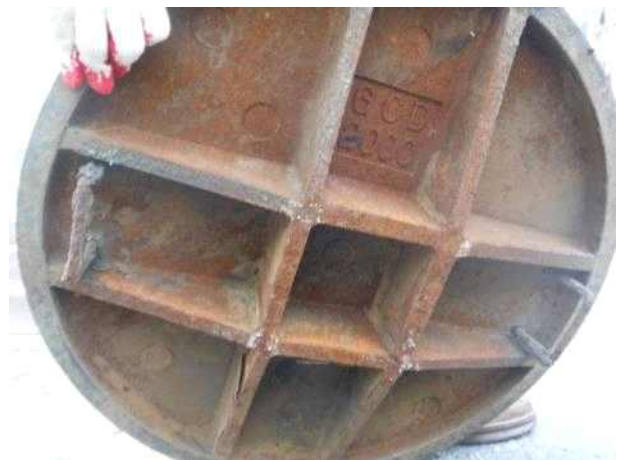
맨홀뚜껑 내부 전경
