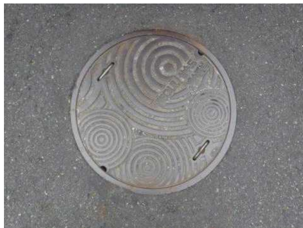
맨홀뚜껑 외부 전경
