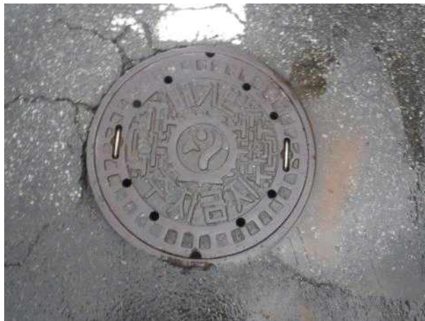
맨홀뚜껑 외부 전경
