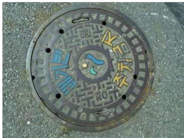
맨홀뚜껑 외부 전경
