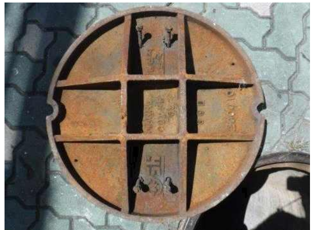
맨홀뚜껑 내부 전경
