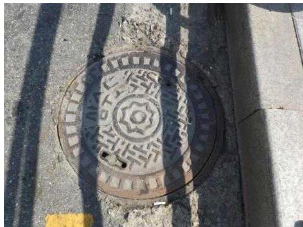
맨홀뚜껑 외부 전경
