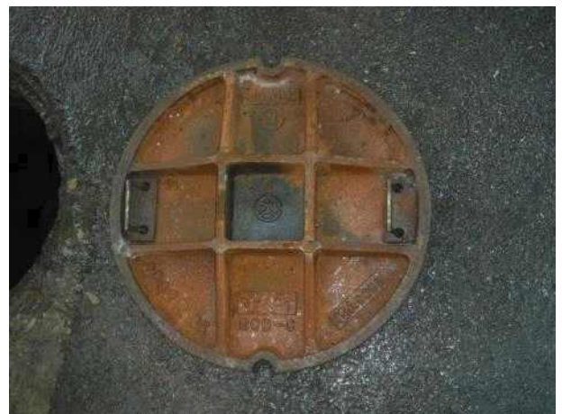
맨홀뚜껑 내부 전경
