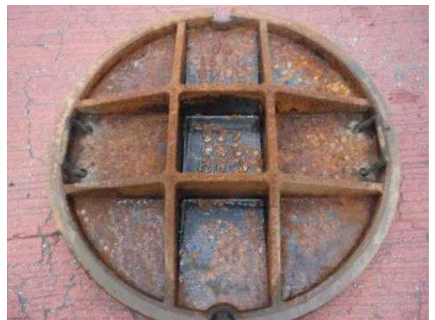
맨홀뚜껑 내부 전경
