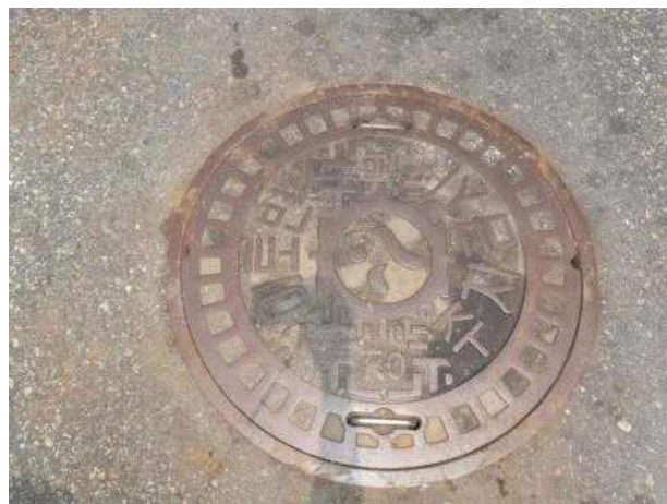
맨홀뚜껑 외부 전경
