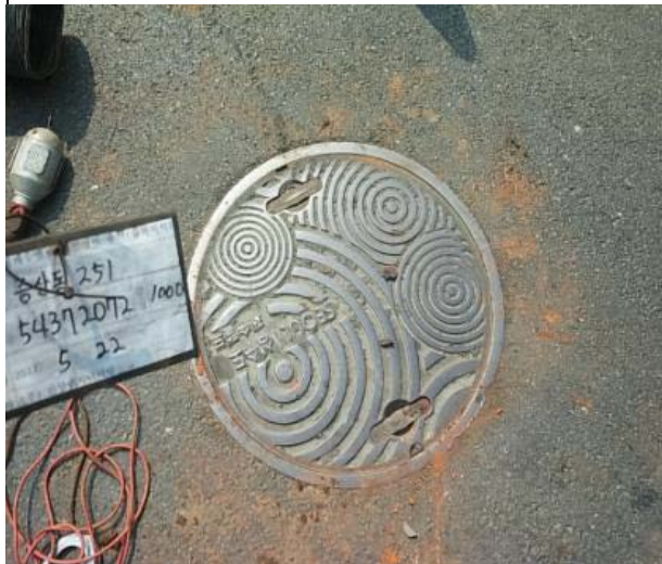
외부 포장 균열
