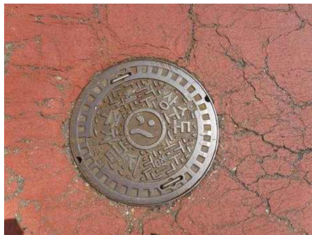
맨홀뚜껑 외부 전경
