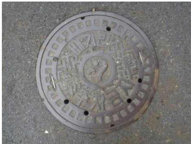
맨홀뚜껑 외부 전경
