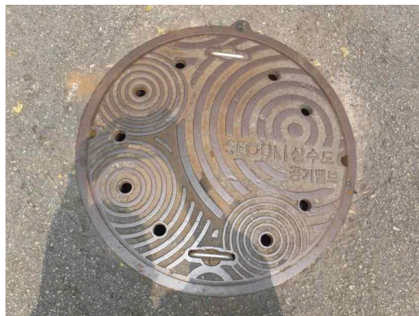
맨홀뚜껑 외부 전경
