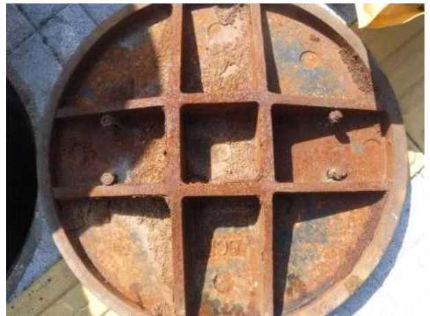
맨홀뚜껑 내부 전경
