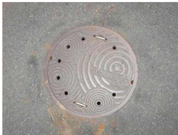
맨홀뚜껑 외부 전경
