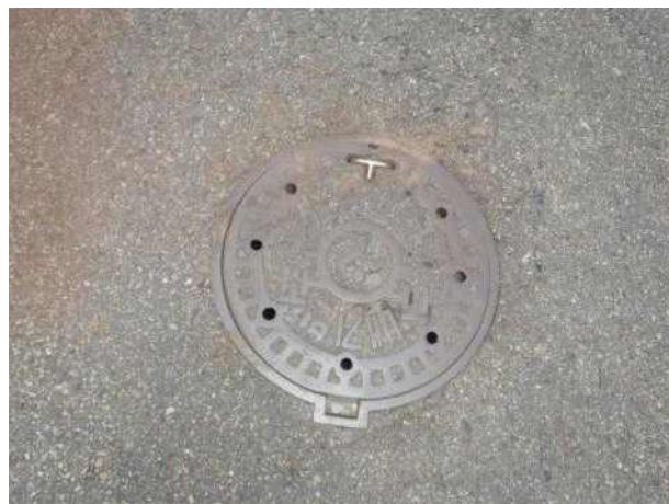
맨홀뚜껑 외부 전경
