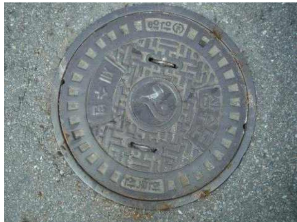
맨홀뚜껑 외부 전경
