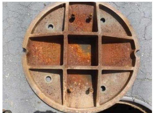
맨홀뚜껑 내부 전경
