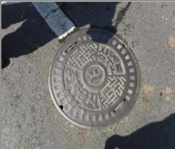
외부 포장 균열
