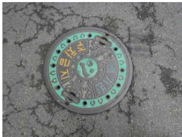
맨홀뚜껑 외부 전경
