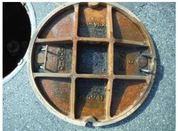
맨홀뚜껑 내부 전경
