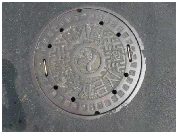
맨홀뚜껑 외부 전경
