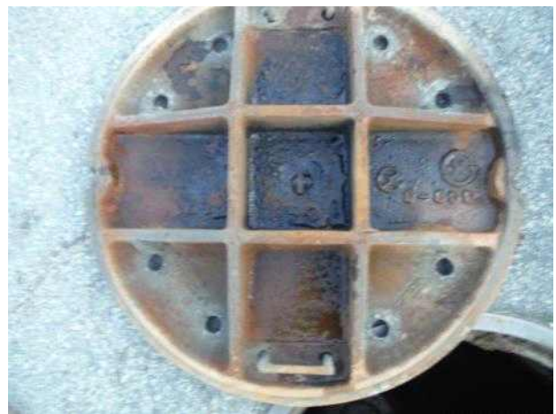
맨홀뚜껑 내부 전경
