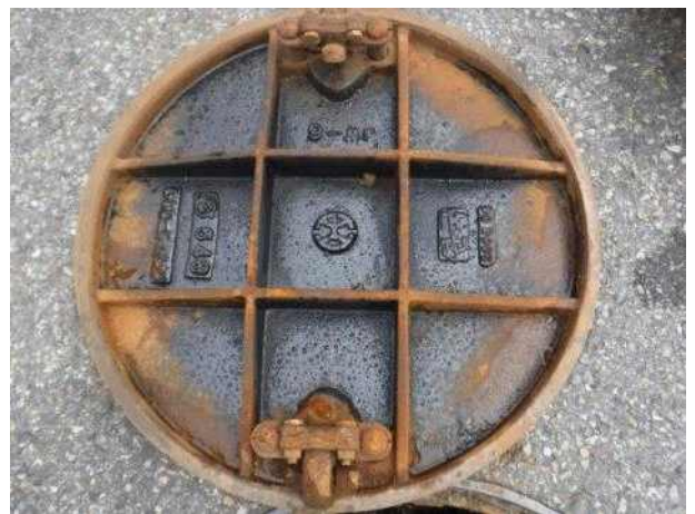
맨홀뚜껑 내부 전경
