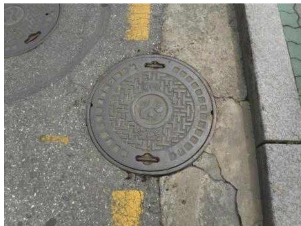
맨홀뚜껑 외부 전경
