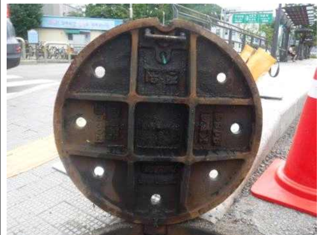
맨홀뚜껑 내부 전경
