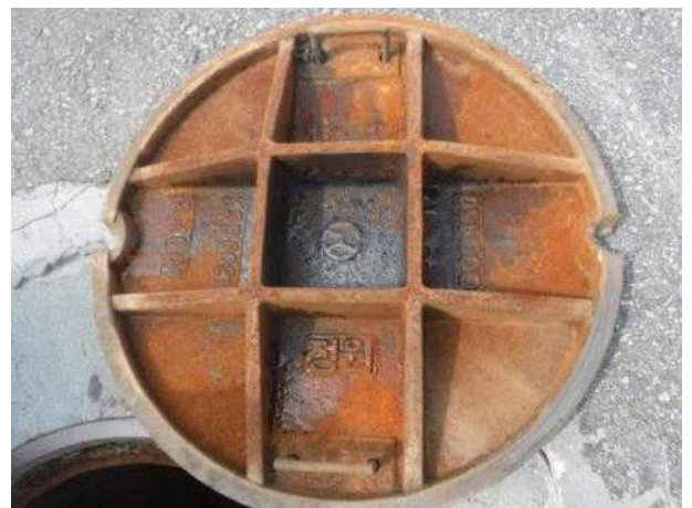
맨홀뚜껑 내부 전경
