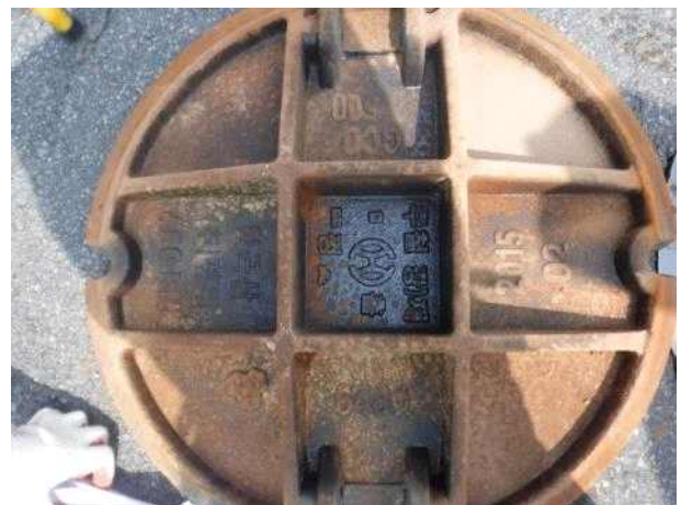
맨홀뚜껑 내부 전경
