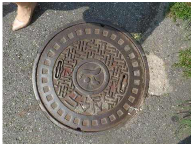
맨홀뚜껑 외부 전경
