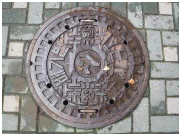
맨홀뚜껑 외부 전경
