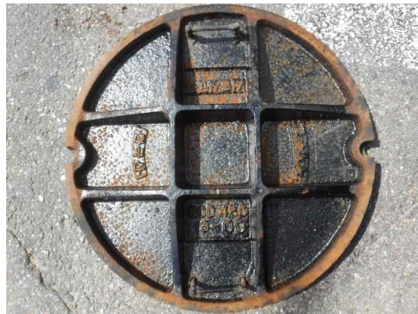
맨홀뚜껑 내부 전경
