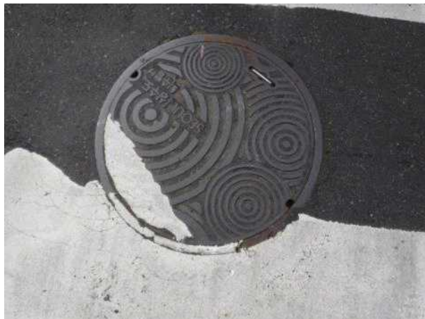
맨홀뚜껑 외부 전경
