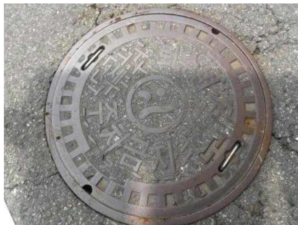
맨홀뚜껑 외부 전경
