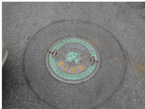
맨홀뚜껑 외부 전경
