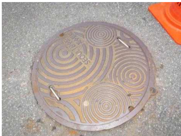
맨홀뚜껑 외부 전경
