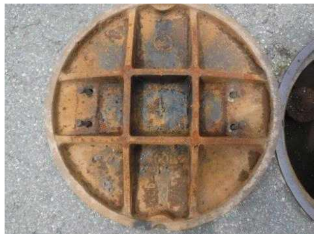
맨홀뚜껑 내부 전경
