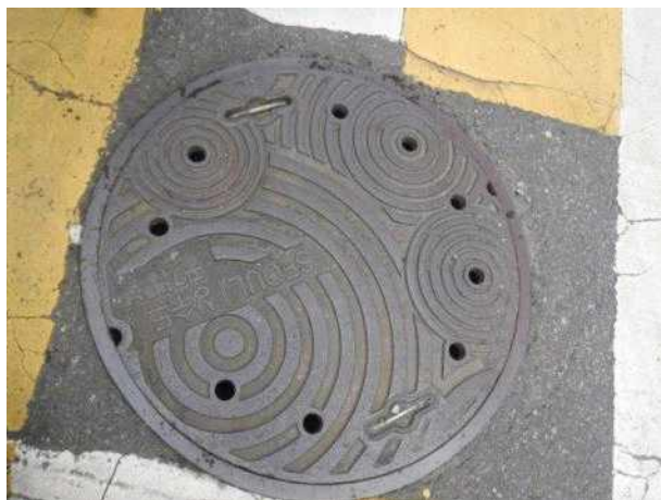
맨홀뚜껑 외부 전경
