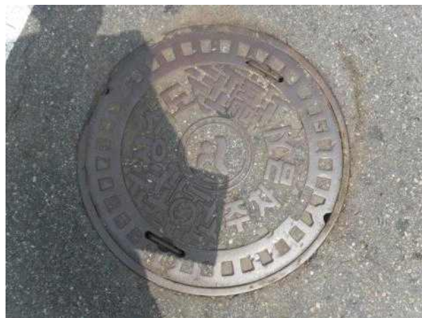
맨홀뚜껑 외부 전경
