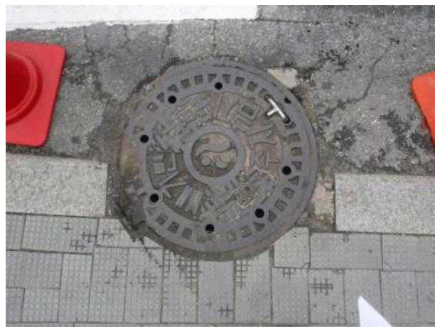
맨홀뚜껑 외부 전경
