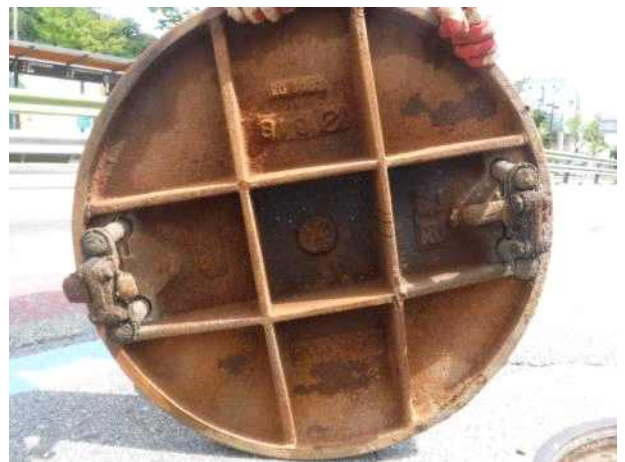
맨홀뚜껑 내부 전경
