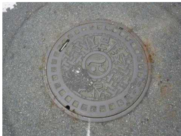
맨홀뚜껑 외부 전경
