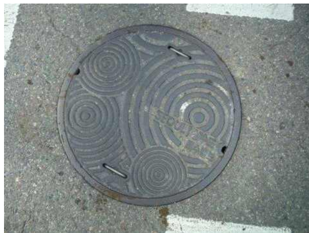
맨홀뚜껑 외부 전경
