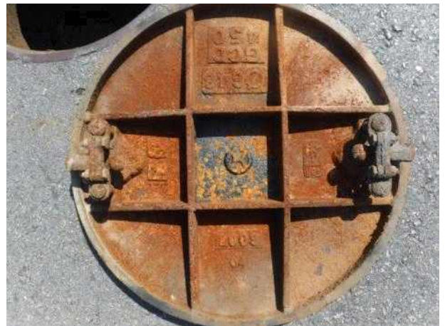
맨홀뚜껑 내부 전경
