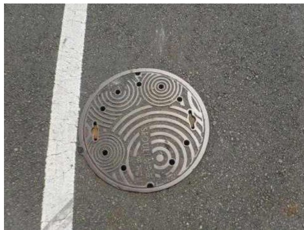
맨홀뚜껑 외부 전경
