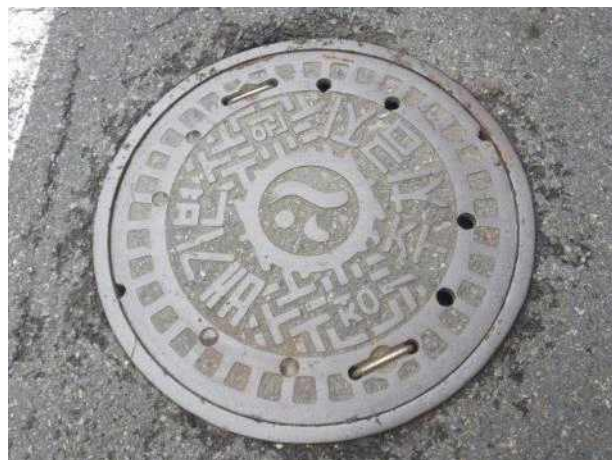
맨홀뚜껑 외부 전경
