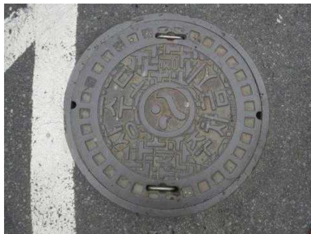
맨홀뚜껑 외부 전경
