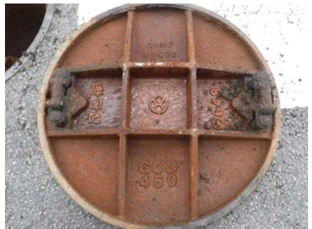
맨홀뚜껑 내부 전경
