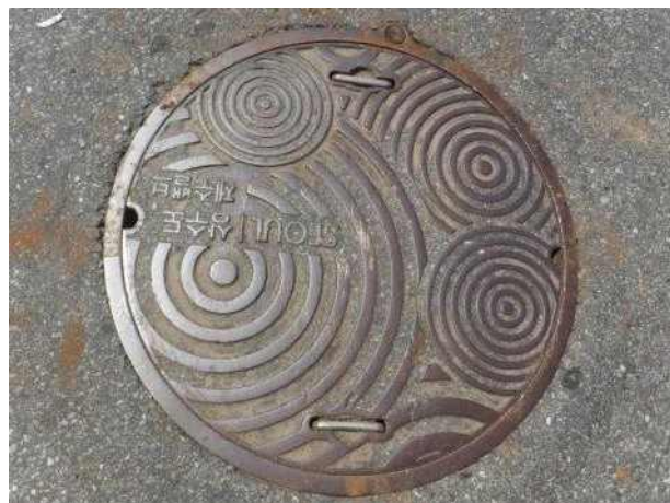
맨홀뚜껑 외부 전경
