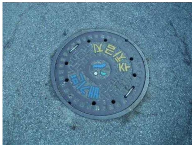
맨홀뚜껑 외부 전경
