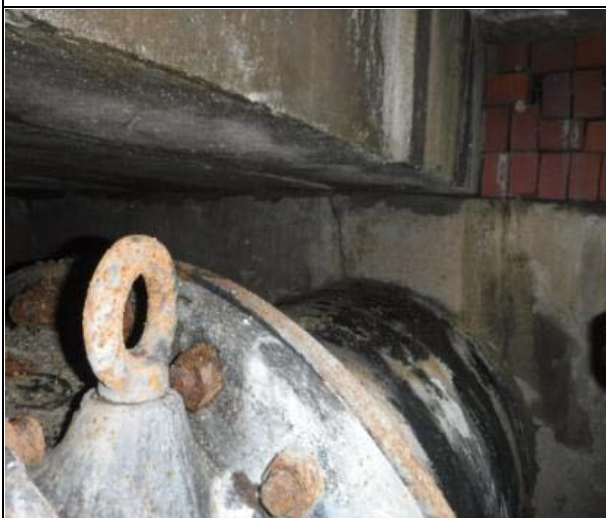
내부 벽체 균열
