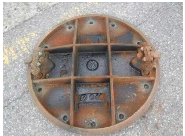
맨홀뚜껑 내부 전경
