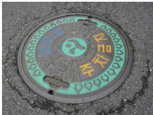
맨홀뚜껑 외부 전경
