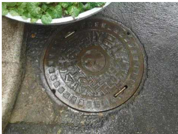
맨홀뚜껑 외부 전경
