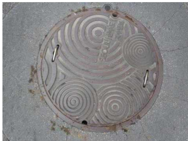
맨홀뚜껑 외부 전경
