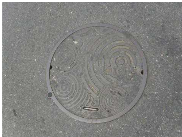
맨홀뚜껑 외부 전경
