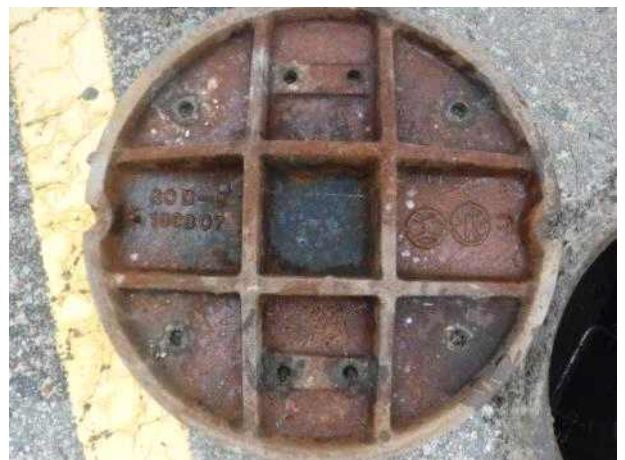
맨홀뚜껑 내부 전경
