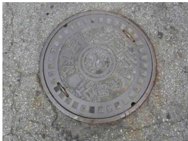
맨홀뚜껑 외부 전경
