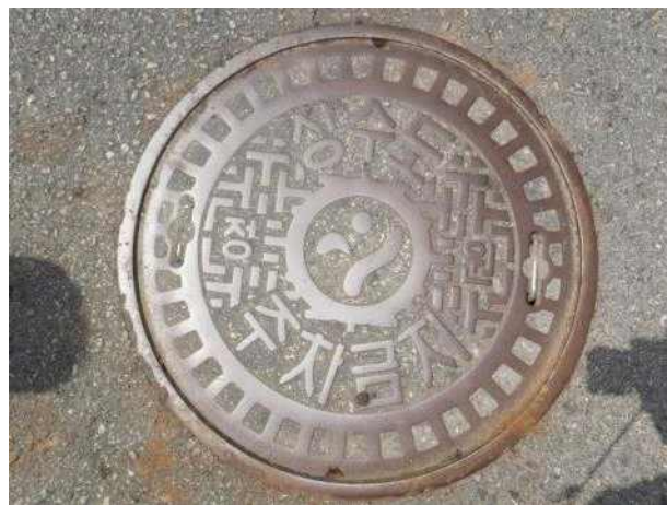
맨홀뚜껑 외부 전경
