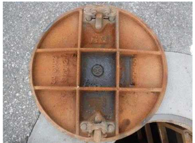
맨홀뚜껑 내부 전경
