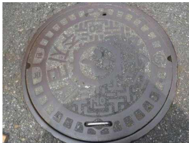
맨홀뚜껑 외부 전경
