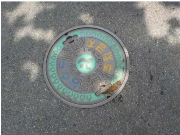
맨홀뚜껑 외부 전경
