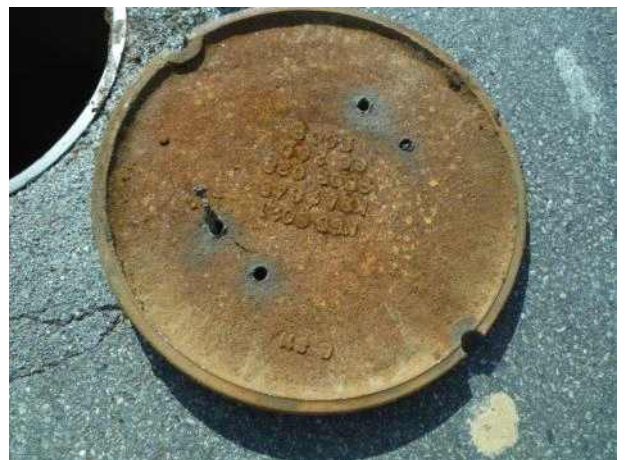
맨홀뚜껑 내부 전경
