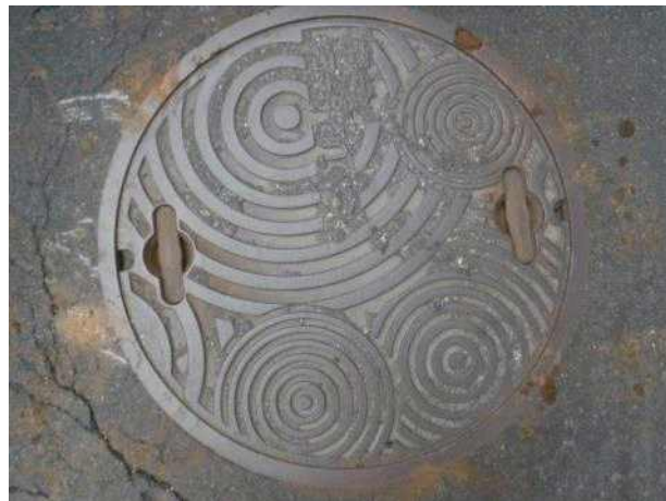
맨홀뚜껑 외부 전경
