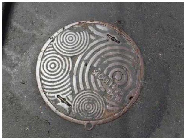
맨홀뚜껑 외부 전경
