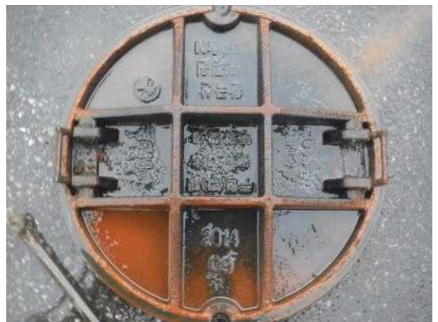
맨홀뚜껑 내부 전경
