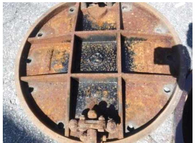
맨홀뚜껑 내부 전경
