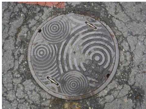
맨홀뚜껑 외부 전경
