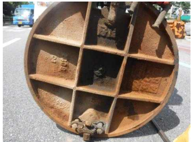
맨홀뚜껑 내부 전경
