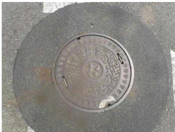
맨홀뚜껑 외부 전경
