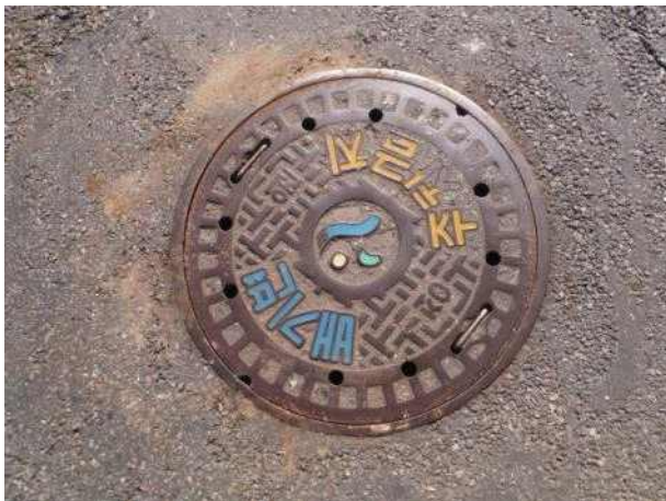
맨홀뚜껑 외부 전경
