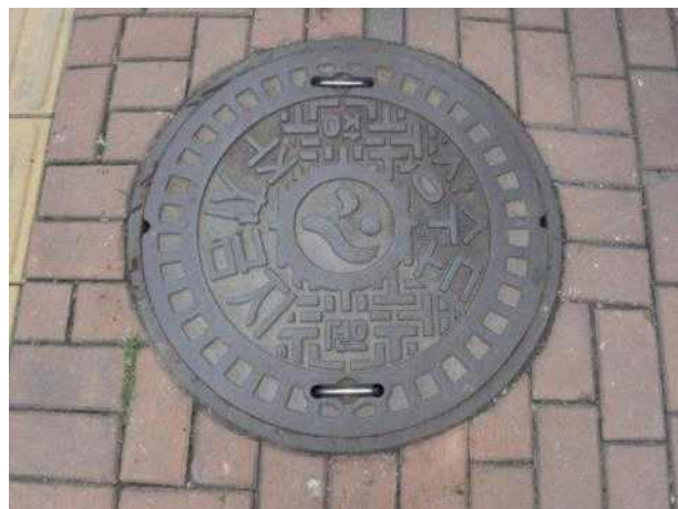
맨홀뚜껑 외부 전경
