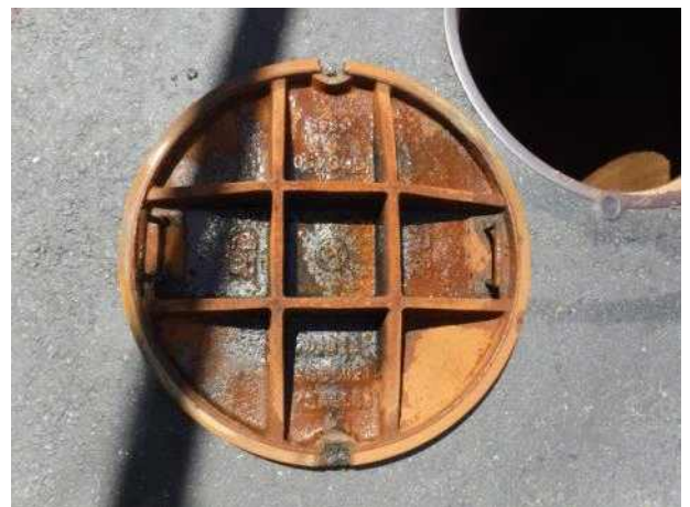
맨홀뚜껑 내부 전경
