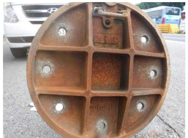
맨홀뚜껑 내부 전경
