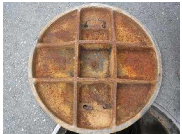
맨홀뚜껑 내부 전경
