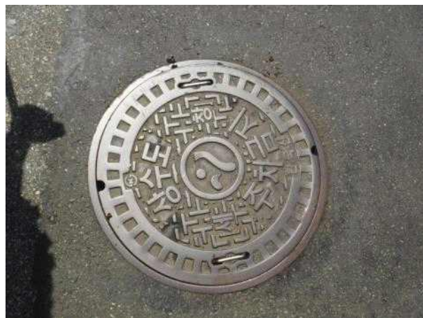
맨홀뚜껑 외부 전경
