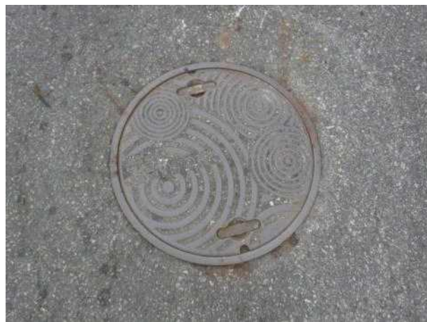
맨홀뚜껑 외부 전경
