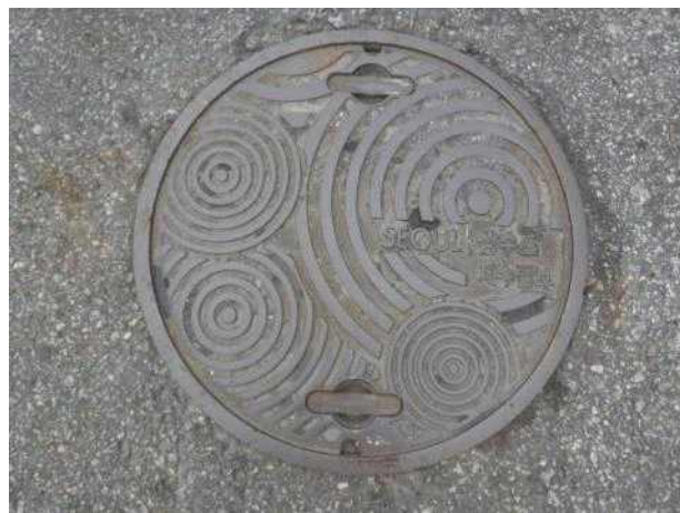
맨홀뚜껑 외부 전경
