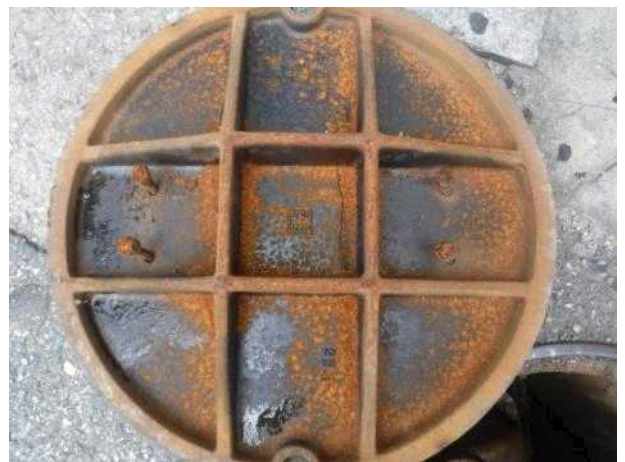
맨홀뚜껑 내부 전경
