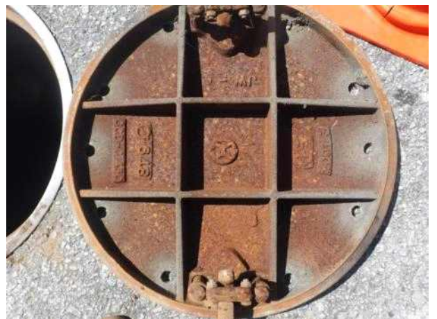
맨홀뚜껑 내부 전경
