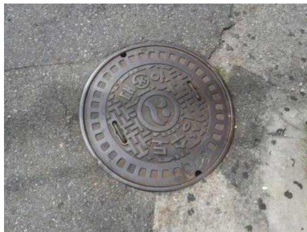
맨홀뚜껑 외부 전경
