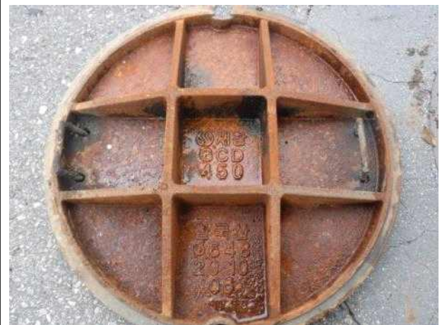
맨홀뚜껑 내부 전경
