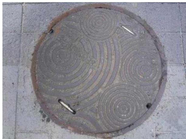
맨홀뚜껑 외부 전경
