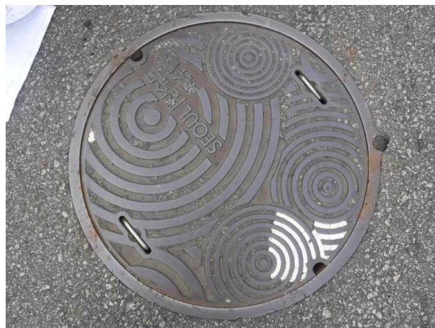
맨홀뚜껑 외부 전경
