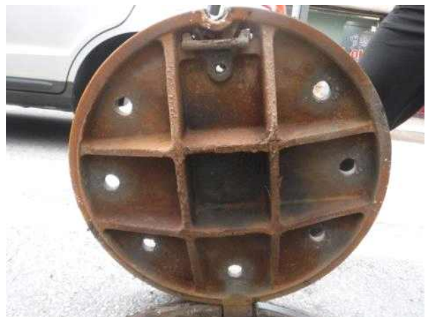
맨홀뚜껑 내부 전경
