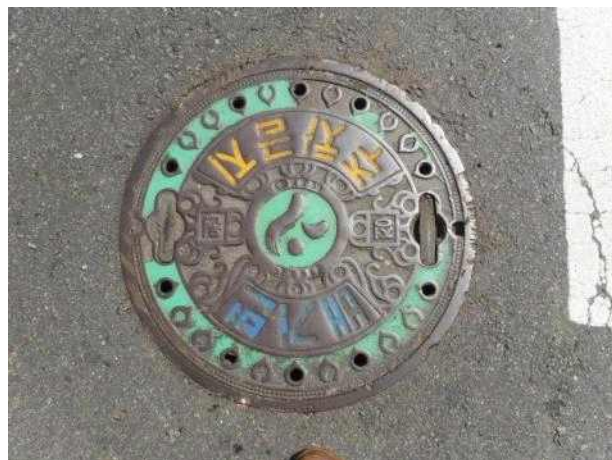
맨홀뚜껑 외부 전경
