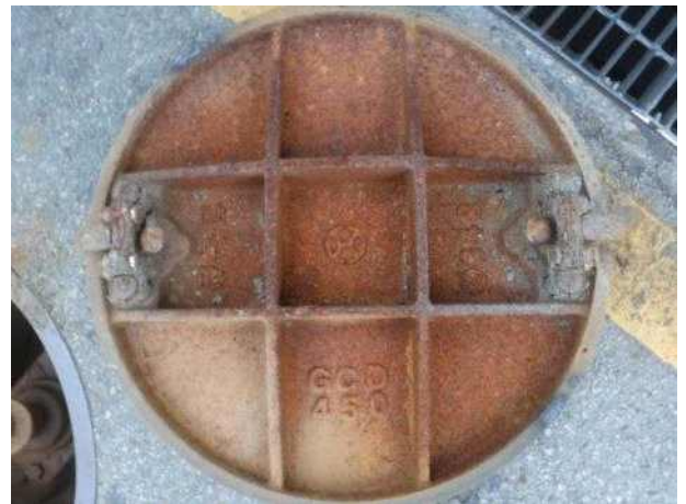
맨홀뚜껑 내부 전경
