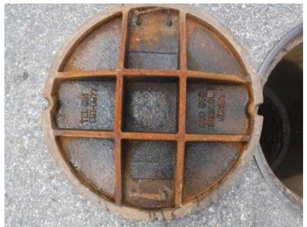
맨홀뚜껑 내부 전경
