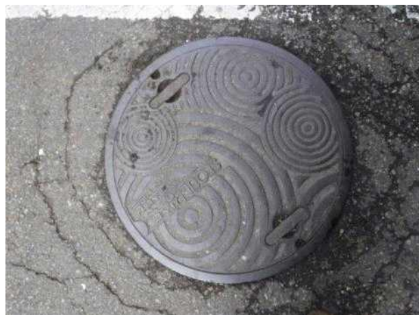
맨홀뚜껑 외부 전경
