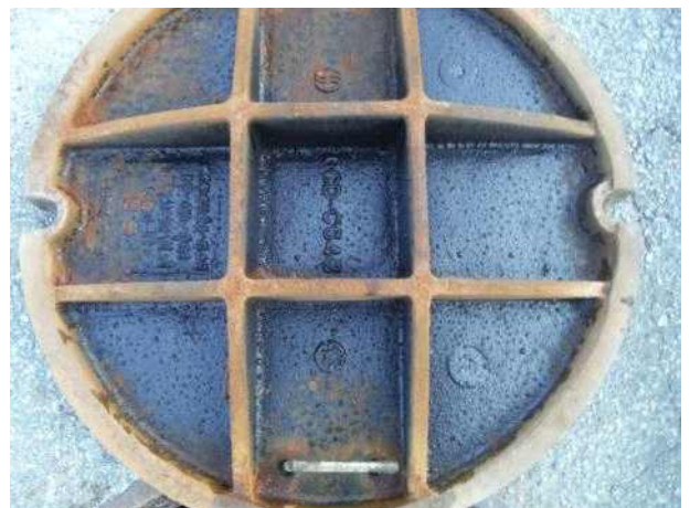
맨홀뚜껑 내부 전경
