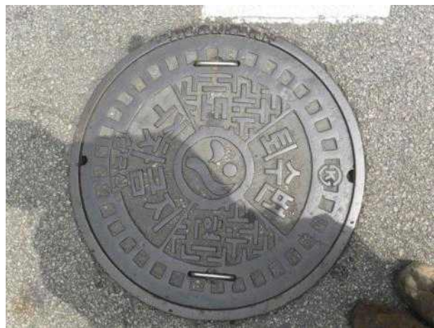
맨홀뚜껑 외부 전경
