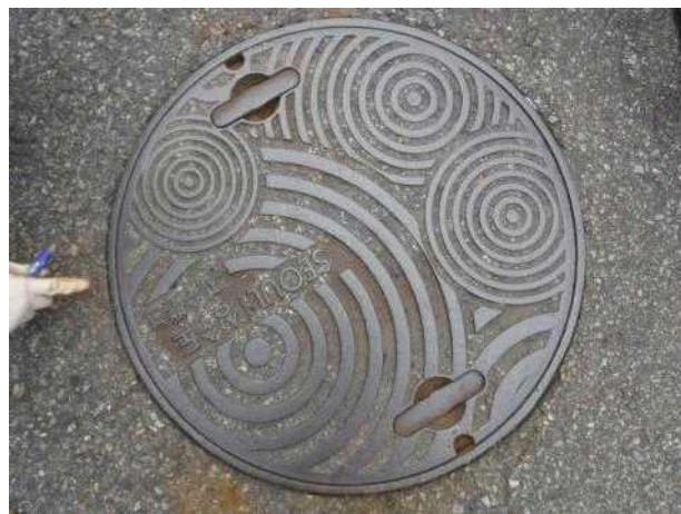
맨홀뚜껑 외부 전경
