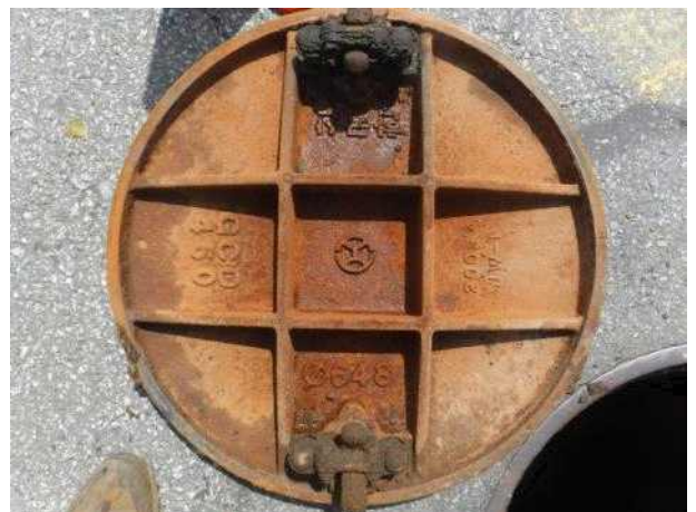
맨홀뚜껑 내부 전경
