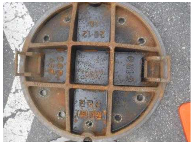
맨홀뚜껑 내부 전경
