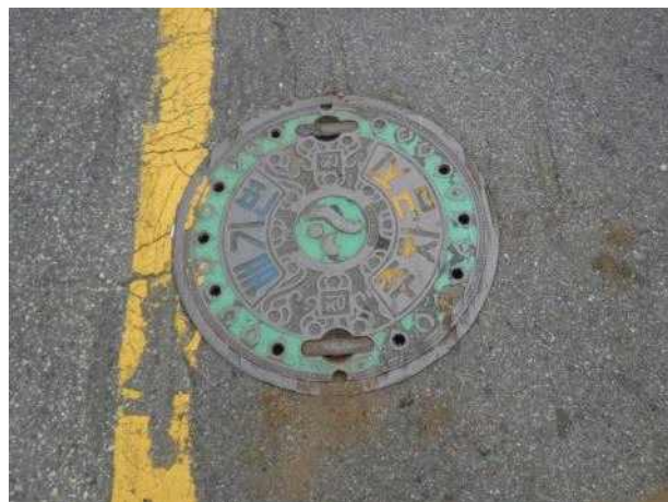
맨홀뚜껑 외부 전경
