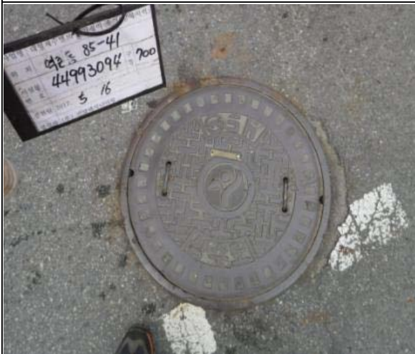
외부 포장 균열
