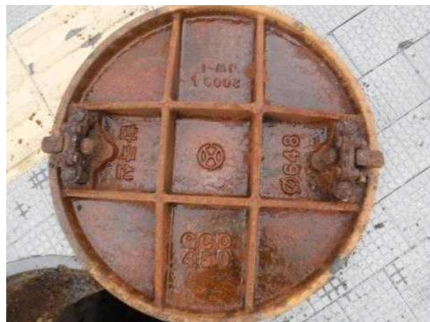
맨홀뚜껑 내부 전경
