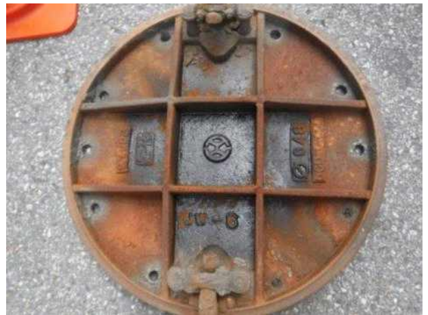
맨홀뚜껑 내부 전경
