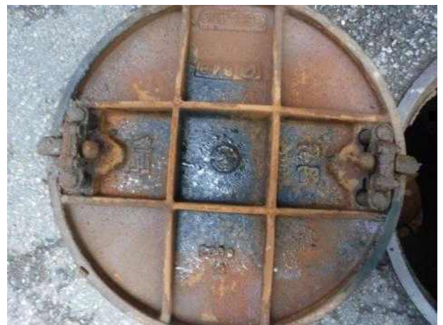
맨홀뚜껑 내부 전경
