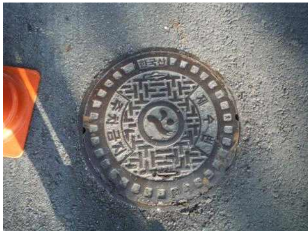
맨홀뚜껑 외부 전경
