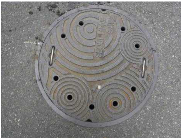
맨홀뚜껑 외부 전경
