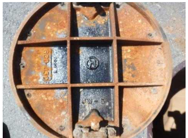
맨홀뚜껑 내부 전경
