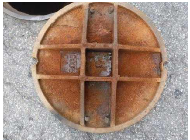
맨홀뚜껑 내부 전경
