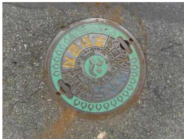
맨홀뚜껑 외부 전경
