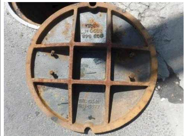
맨홀뚜껑 내부 전경
