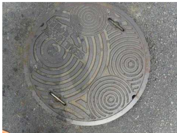
맨홀뚜껑 외부 전경
