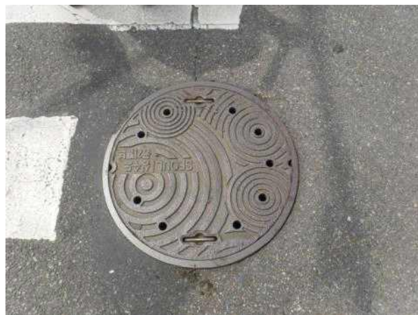
맨홀뚜껑 외부 전경
