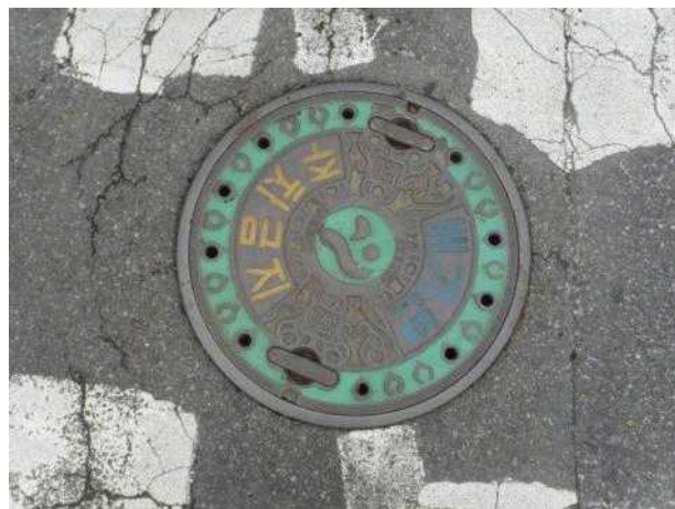
맨홀뚜껑 외부 전경
