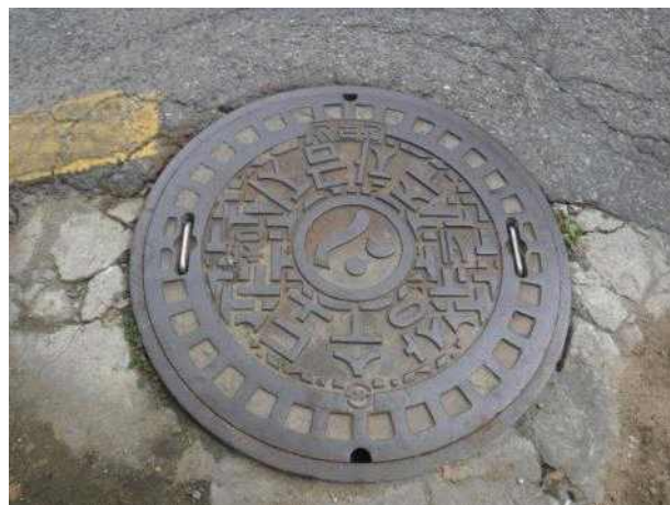
맨홀뚜껑 외부 전경
