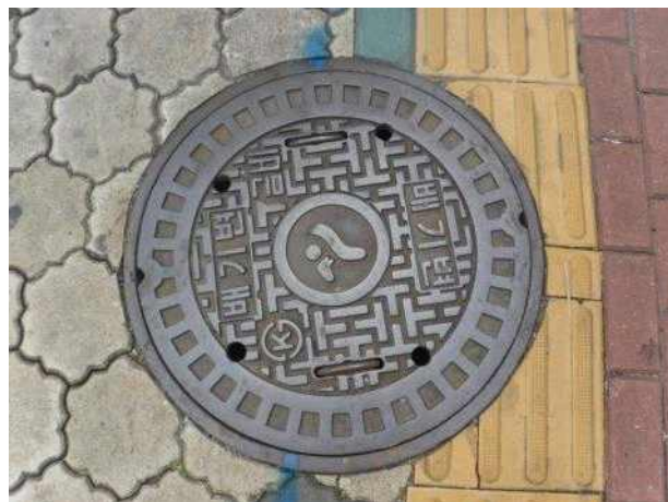
맨홀뚜껑 외부 전경
