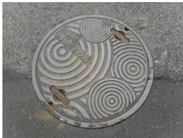
맨홀뚜껑 외부 전경
