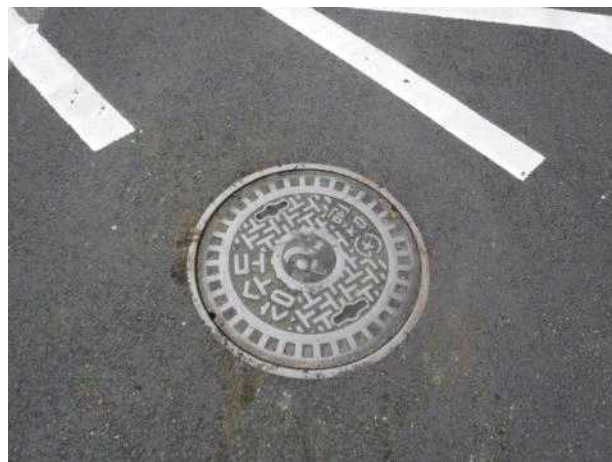
맨홀뚜껑 외부 전경
