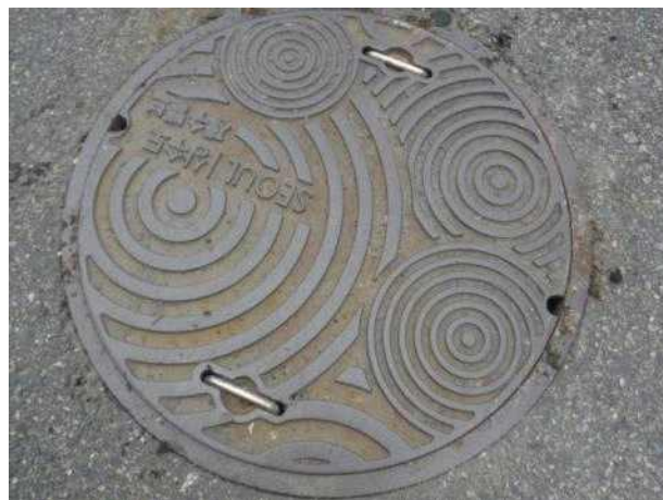
맨홀뚜껑 외부 전경
