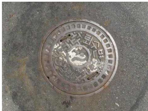
맨홀뚜껑 외부 전경
