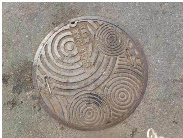
맨홀뚜껑 외부 전경
