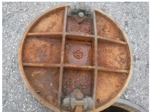
맨홀뚜껑 내부 전경
