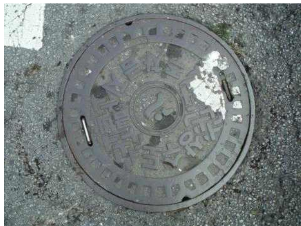
맨홀뚜껑 외부 전경
