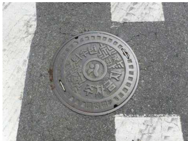
맨홀뚜껑 외부 전경
