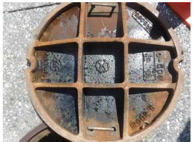
맨홀뚜껑 내부 전경
