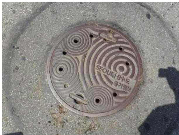
맨홀뚜껑 외부 전경
