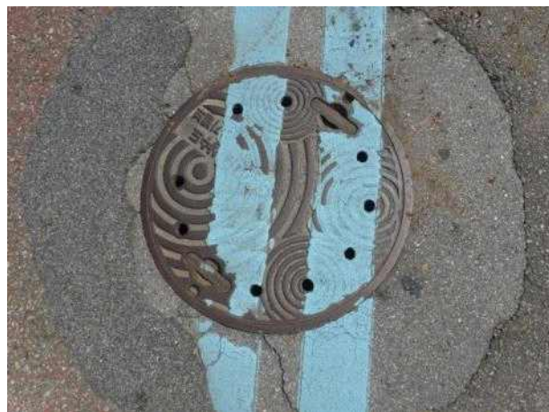
맨홀뚜껑 외부 전경
