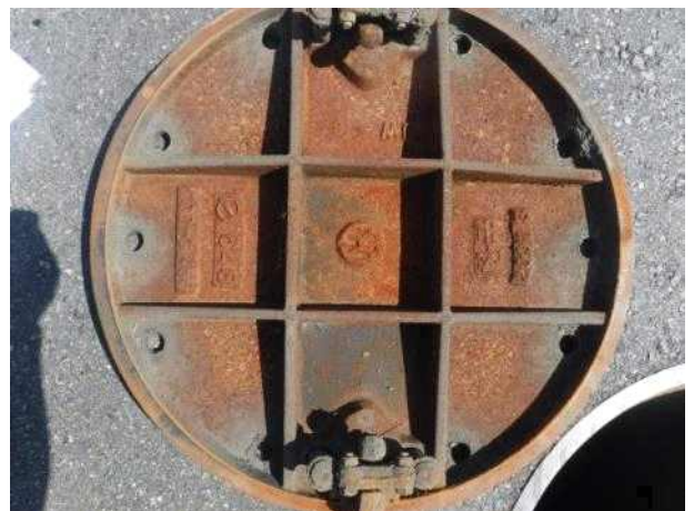
맨홀뚜껑 내부 전경
