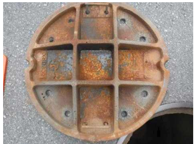
맨홀뚜껑 내부 전경
