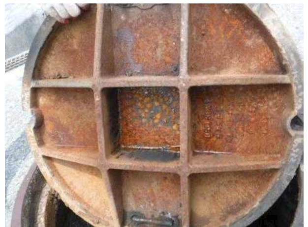
맨홀뚜껑 내부 전경
