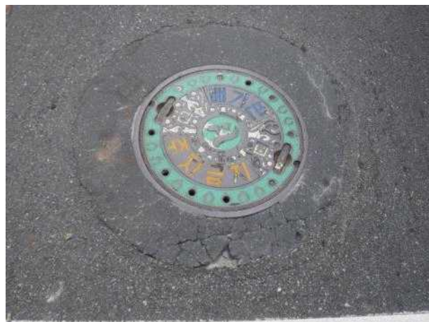
맨홀뚜껑 외부 전경
