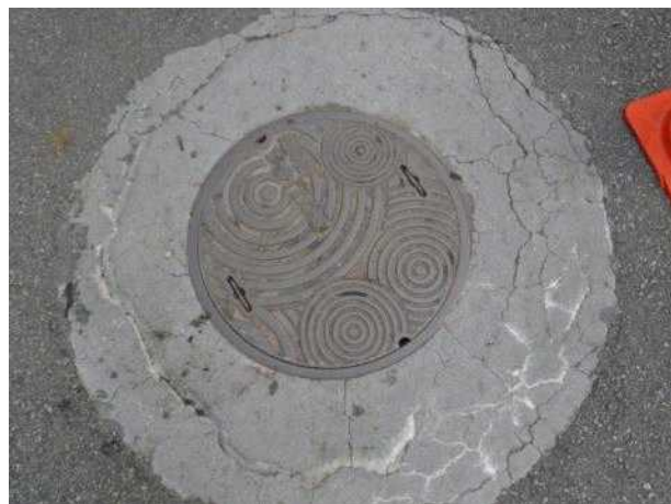
맨홀뚜껑 외부 전경
