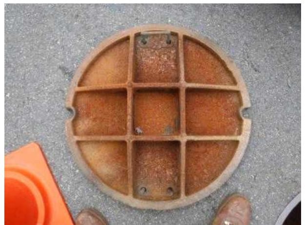
맨홀뚜껑 내부 전경
