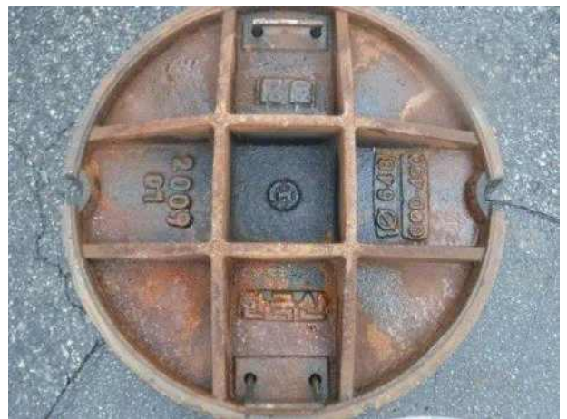
맨홀뚜껑 내부 전경
