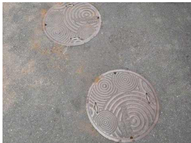
맨홀뚜껑 외부 전경
