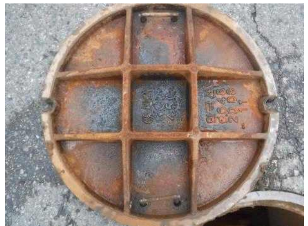
맨홀뚜껑 내부 전경
