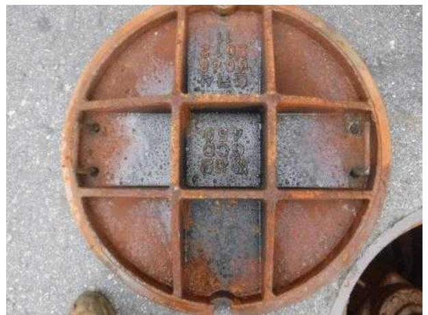
맨홀뚜껑 내부 전경
