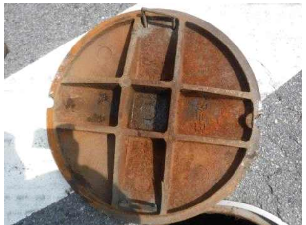
맨홀뚜껑 내부 전경
