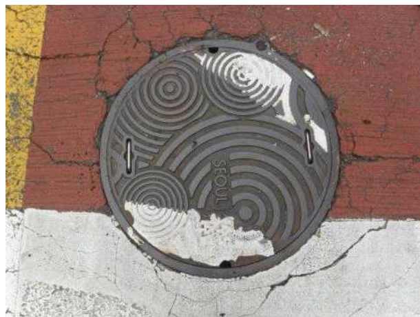
맨홀뚜껑 외부 전경
