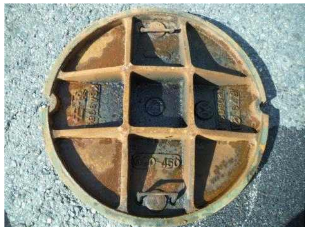
맨홀뚜껑 내부 전경
