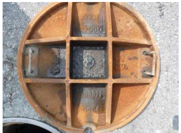
맨홀뚜껑 내부 전경
