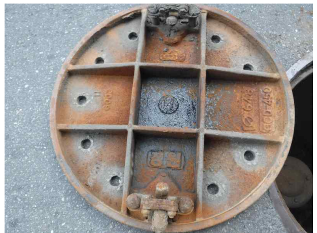
맨홀뚜껑 내부 전경
