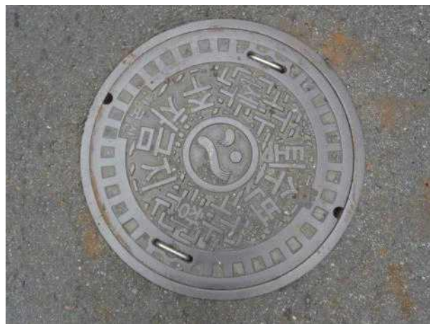
맨홀뚜껑 외부 전경
