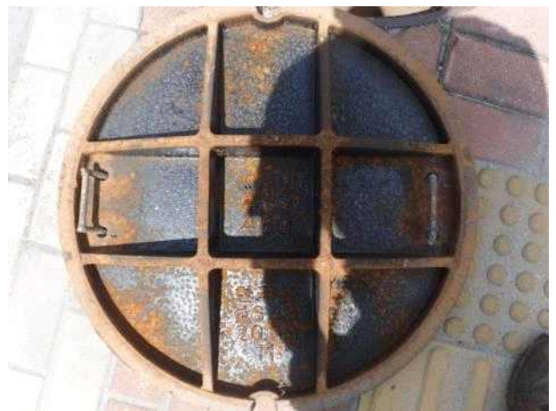
맨홀뚜껑 내부 전경
