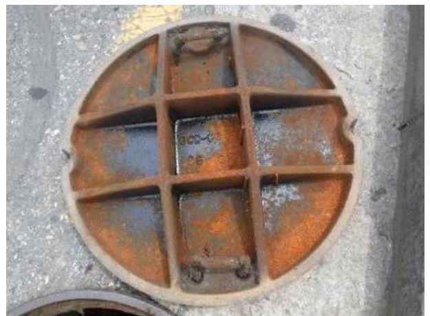
맨홀뚜껑 내부 전경
