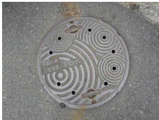
맨홀뚜껑 외부 전경
