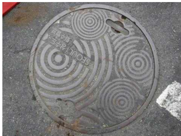
맨홀뚜껑 외부 전경
