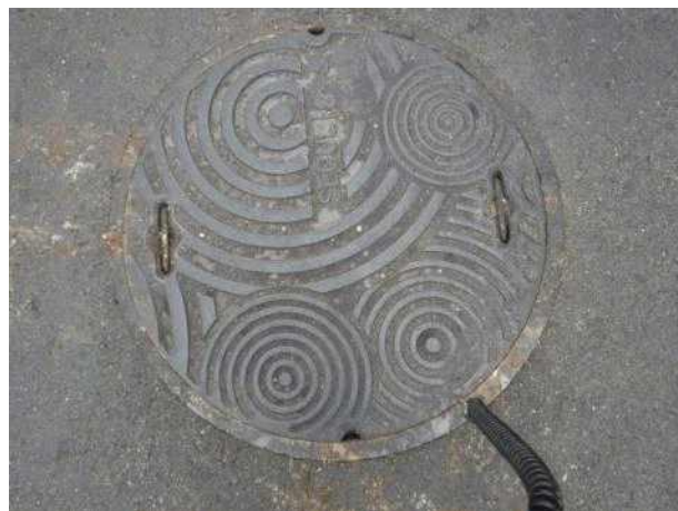
맨홀뚜껑 외부 전경
