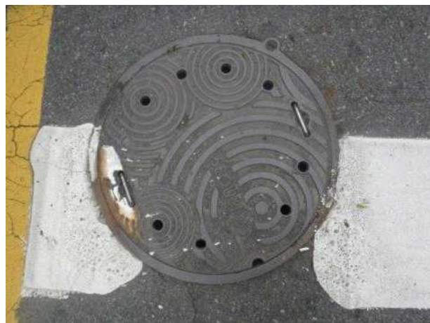
맨홀뚜껑 외부 전경
