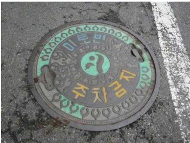
맨홀뚜껑 외부 전경
