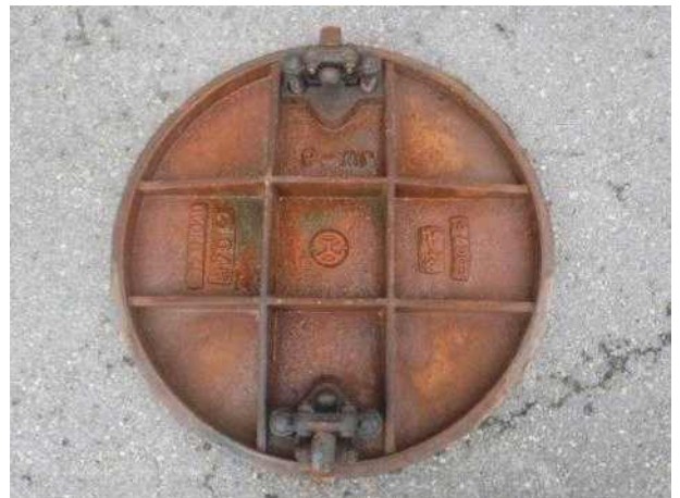
맨홀뚜껑 내부 전경
