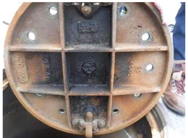
맨홀뚜껑 내부 전경
