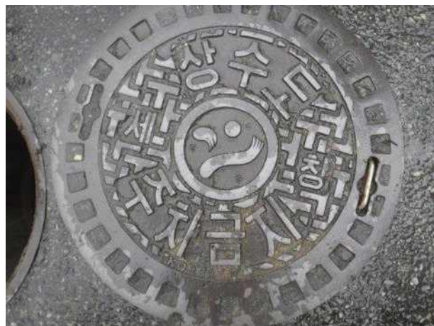
맨홀뚜껑 외부 전경
