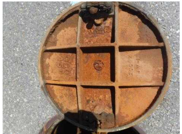
맨홀뚜껑 내부 전경
