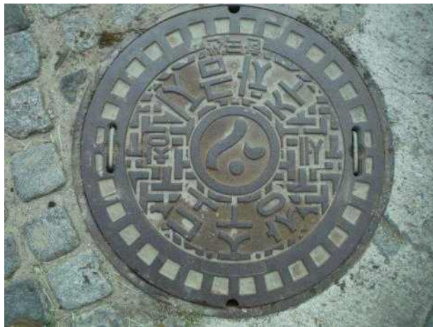
맨홀뚜껑 외부 전경
