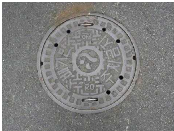
맨홀뚜껑 외부 전경
