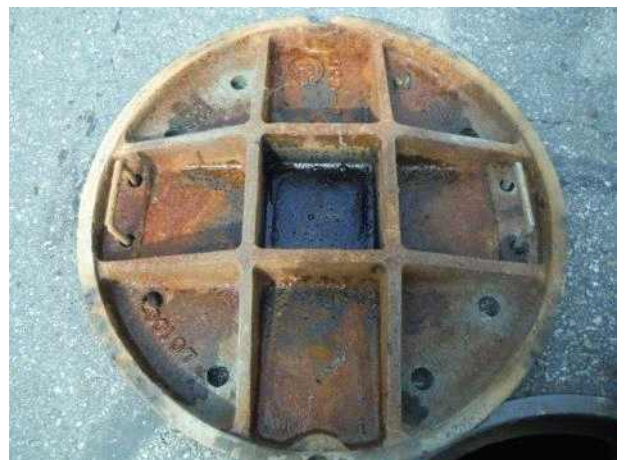
맨홀뚜껑 내부 전경
