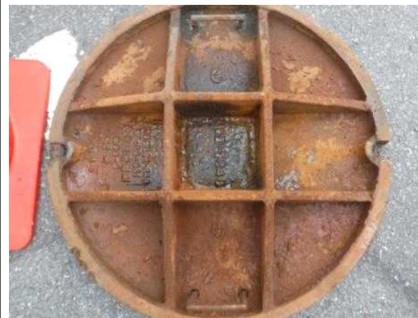
맨홀뚜껑 내부 전경
