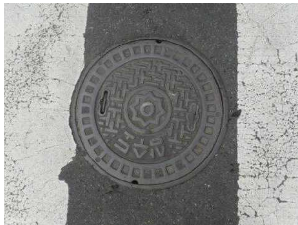
맨홀뚜껑 외부 전경
