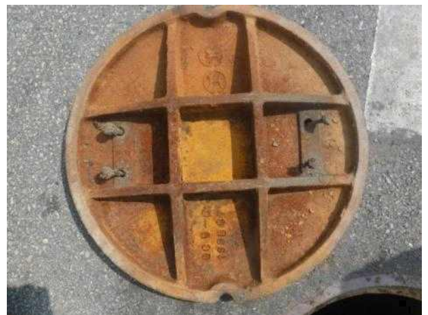
맨홀뚜껑 내부 전경
