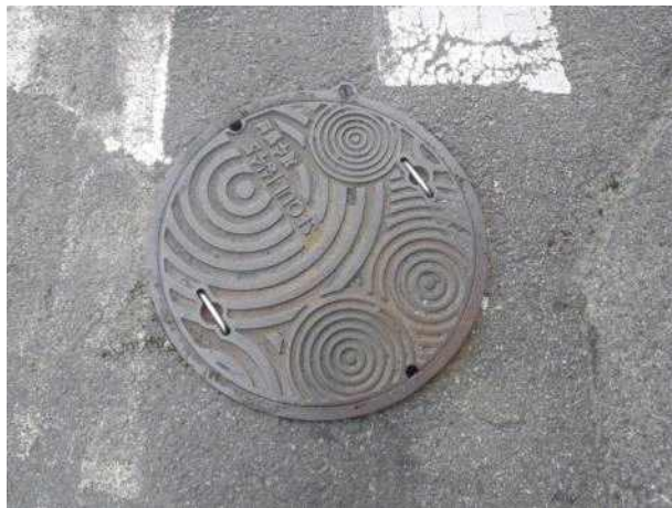
맨홀뚜껑 외부 전경
