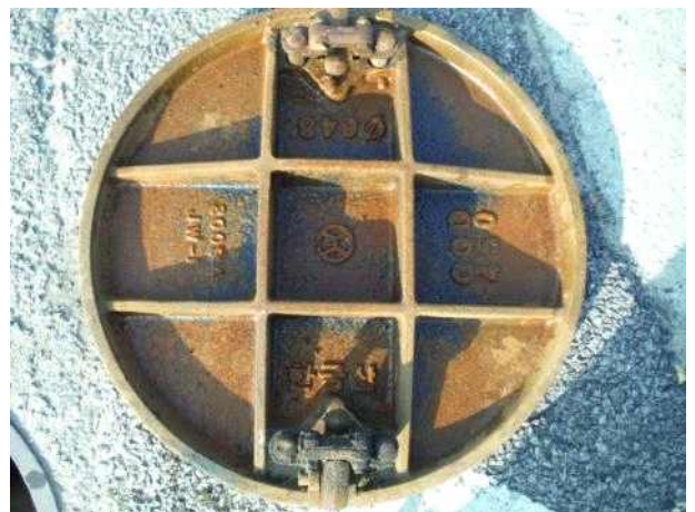
맨홀뚜껑 내부 전경
