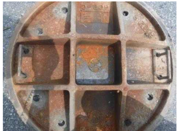
맨홀뚜껑 내부 전경
