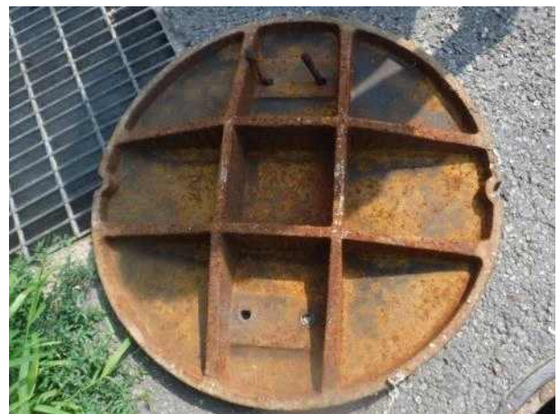
맨홀뚜껑 내부 전경
