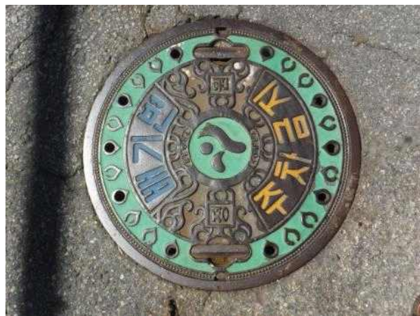
맨홀뚜껑 외부 전경
