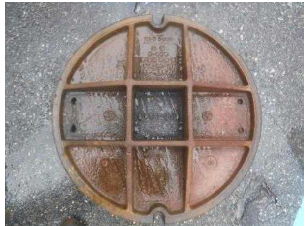
맨홀뚜껑 내부 전경
