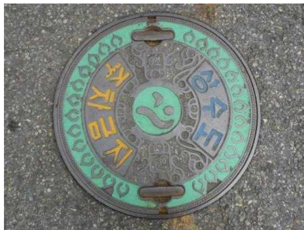
맨홀뚜껑 외부 전경
