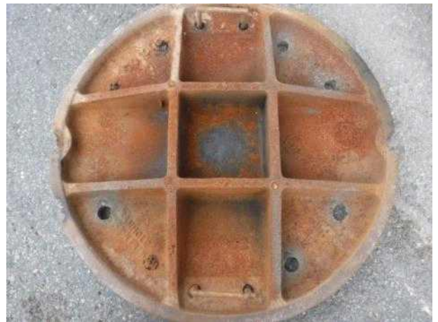
맨홀뚜껑 내부 전경
