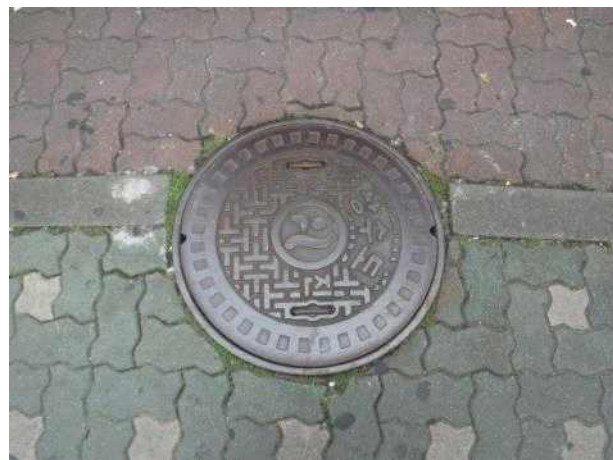
맨홀뚜껑 외부 전경
