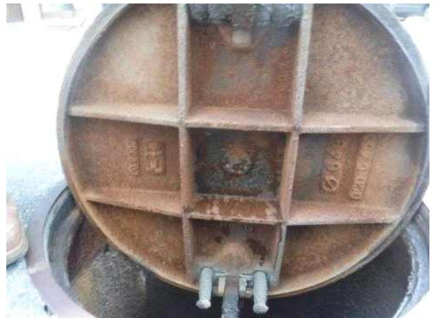
맨홀뚜껑 내부 전경
