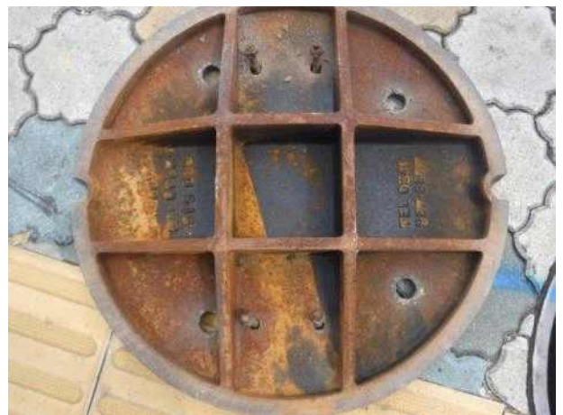
맨홀뚜껑 내부 전경
