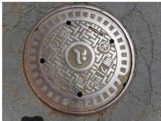
맨홀뚜껑 외부 전경
