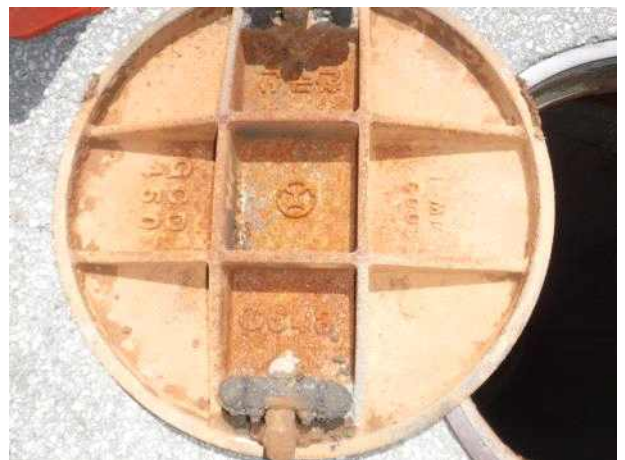
맨홀뚜껑 내부 전경
