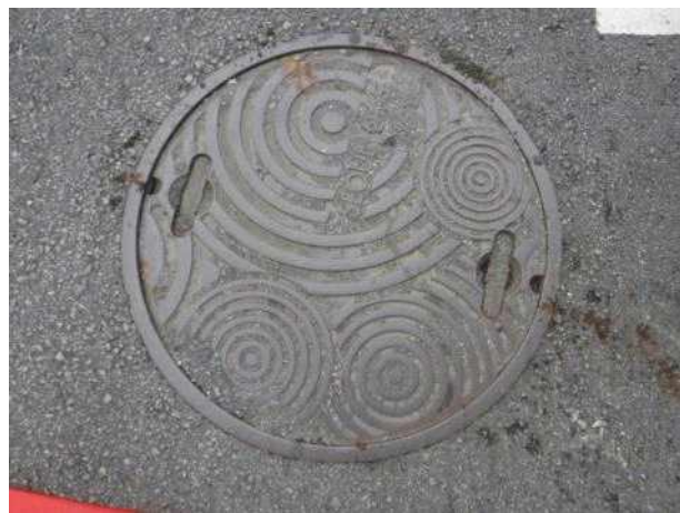
맨홀뚜껑 외부 전경
