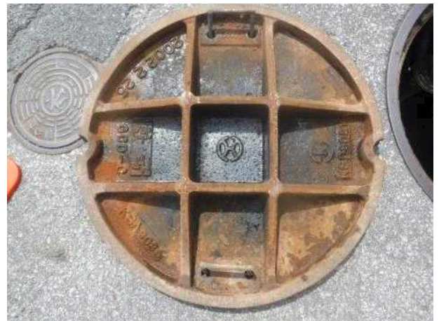
맨홀뚜껑 내부 전경
