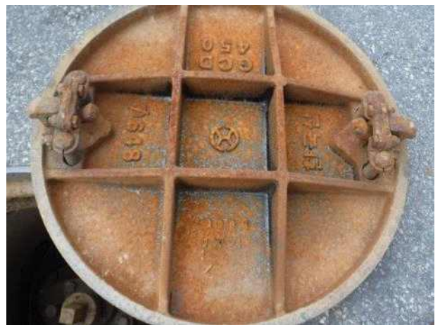
맨홀뚜껑 내부 전경
