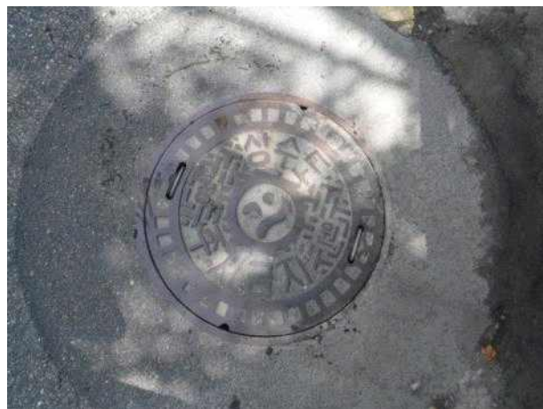
맨홀뚜껑 외부 전경
