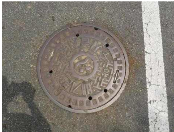
맨홀뚜껑 외부 전경
