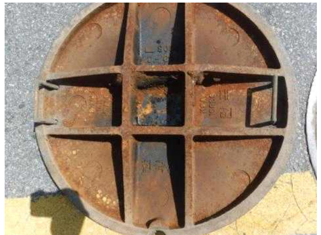
맨홀뚜껑 내부 전경
