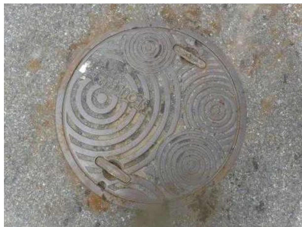
맨홀뚜껑 외부 전경
