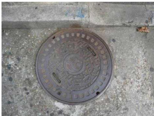
맨홀뚜껑 외부 전경
