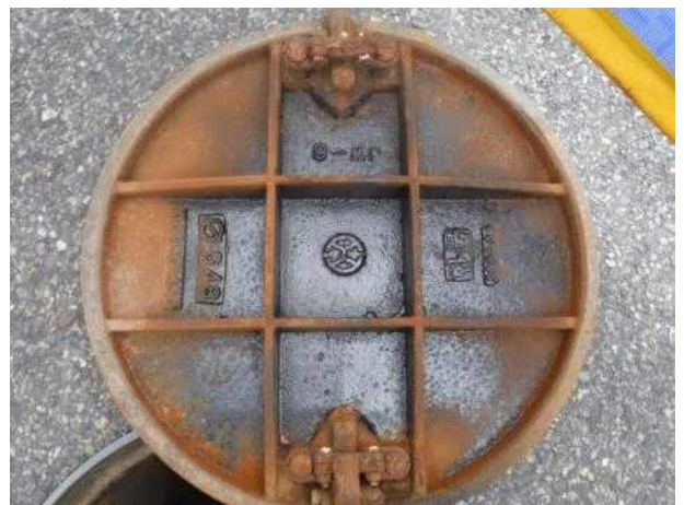
맨홀뚜껑 내부 전경
