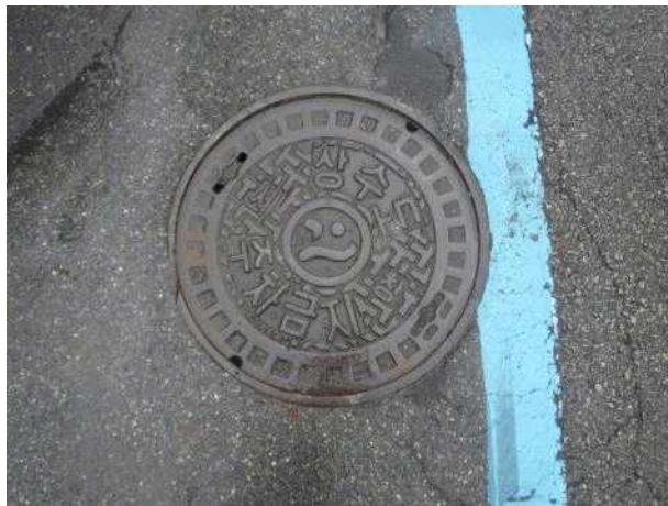
맨홀뚜껑 외부 전경
