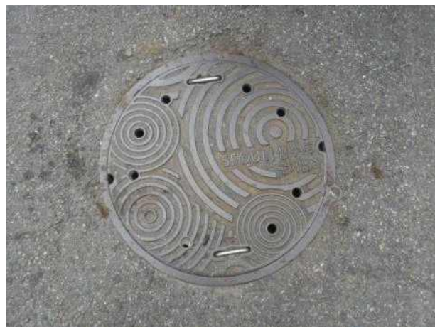
맨홀뚜껑 외부 전경
