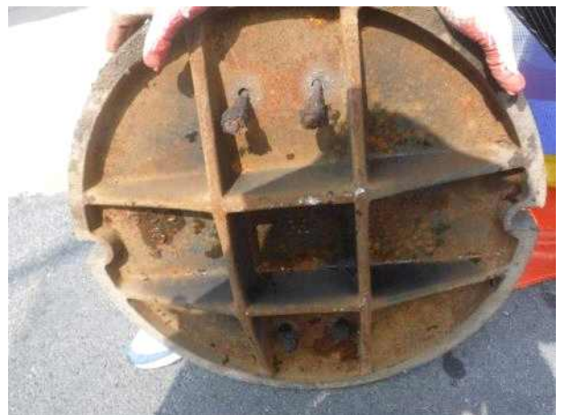
맨홀뚜껑 내부 전경
