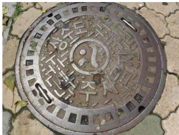
맨홀뚜껑 외부 전경
