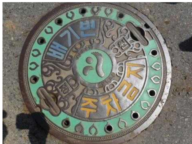
맨홀뚜껑 외부 전경
