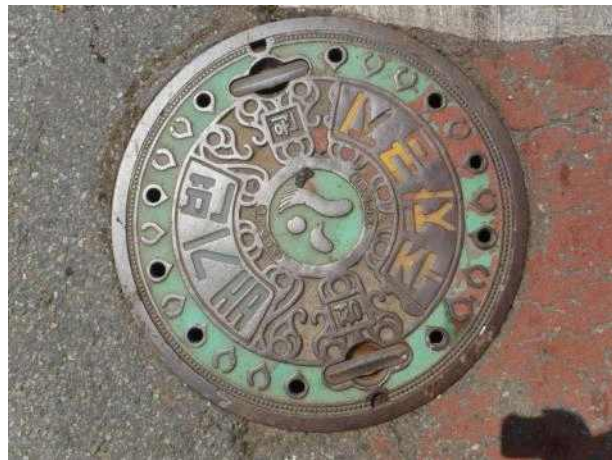
맨홀뚜껑 외부 전경
