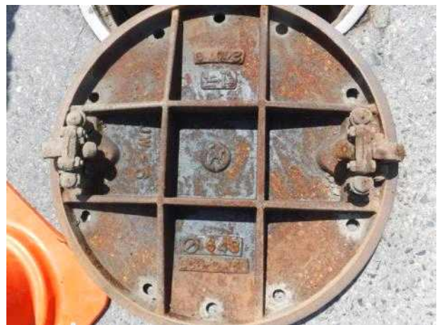
맨홀뚜껑 내부 전경
