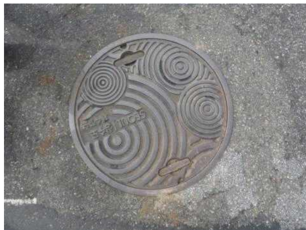
맨홀뚜껑 외부 전경
