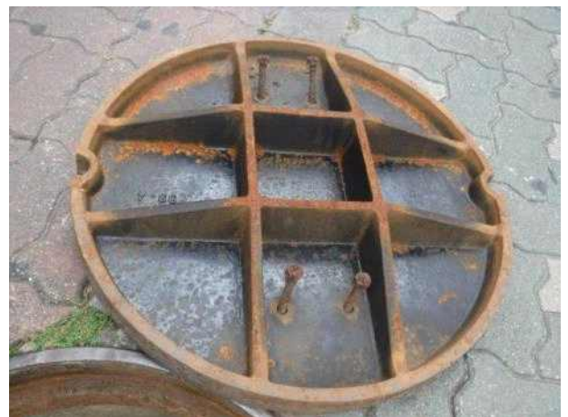
맨홀뚜껑 내부 전경
