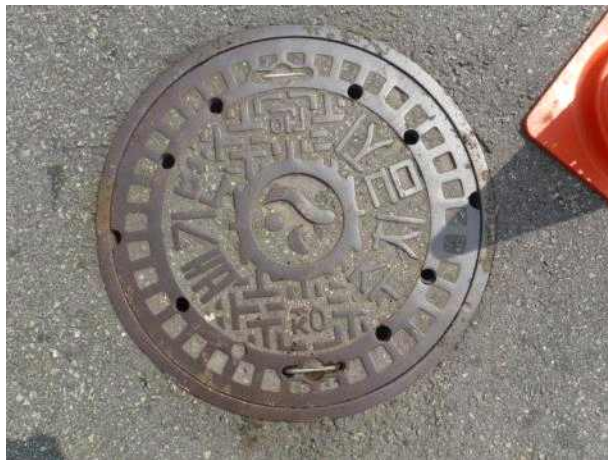
맨홀뚜껑 외부 전경
