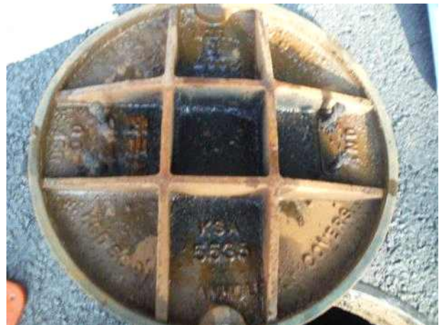
맨홀뚜껑 내부 전경
