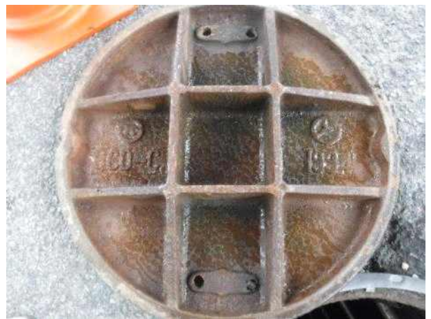
맨홀뚜껑 내부 전경
