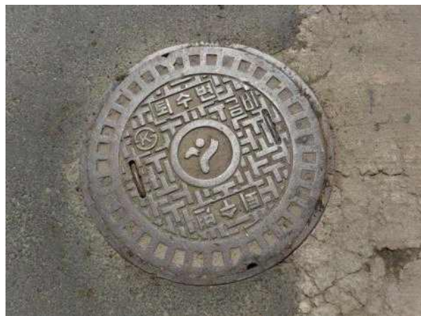
맨홀뚜껑 외부 전경
