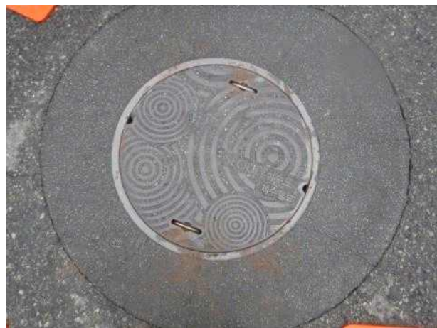
맨홀뚜껑 외부 전경
