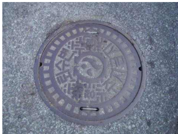
맨홀뚜껑 외부 전경
