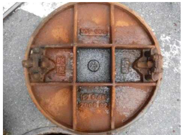
맨홀뚜껑 내부 전경
