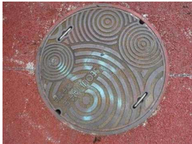
맨홀뚜껑 외부 전경
