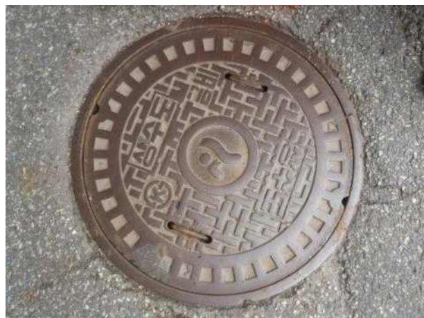
맨홀뚜껑 외부 전경
