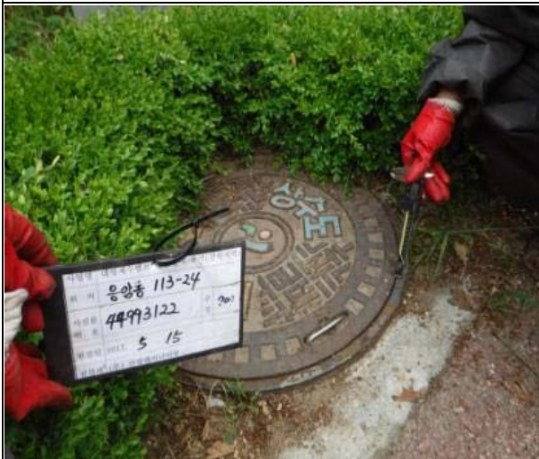
외부 포장 균열
