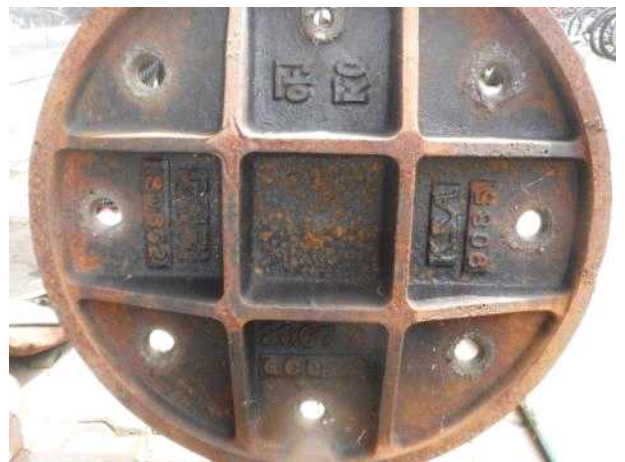
맨홀뚜껑 내부 전경
