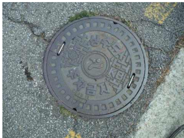
맨홀뚜껑 외부 전경
