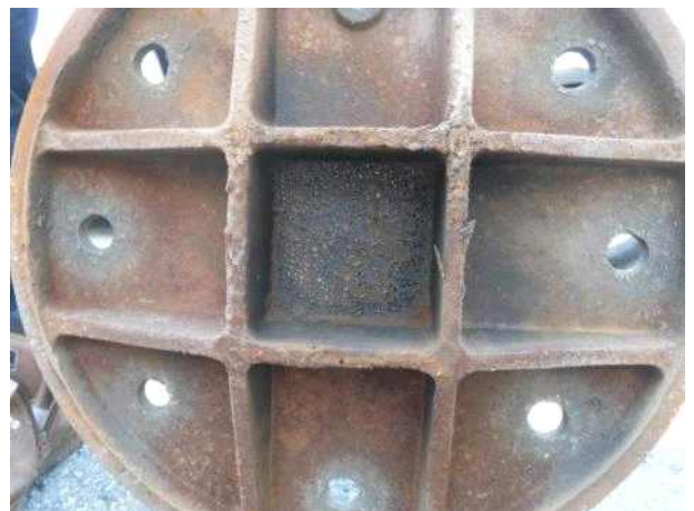
맨홀뚜껑 내부 전경
