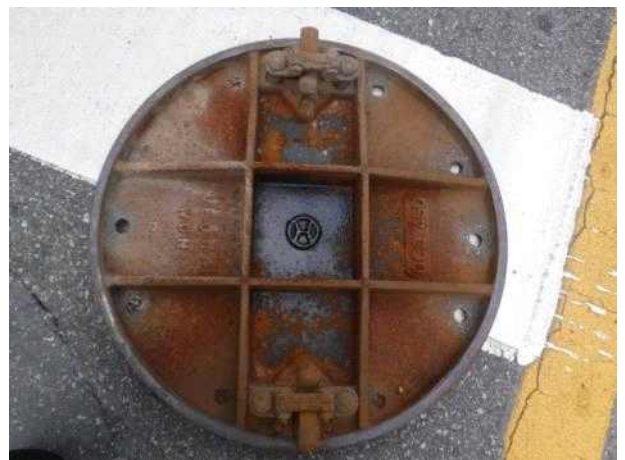
맨홀뚜껑 내부 전경
