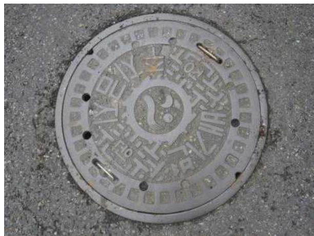
맨홀뚜껑 외부 전경
