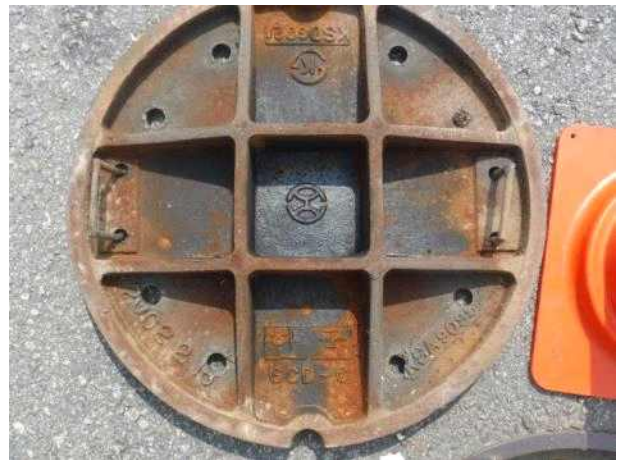
맨홀뚜껑 내부 전경
