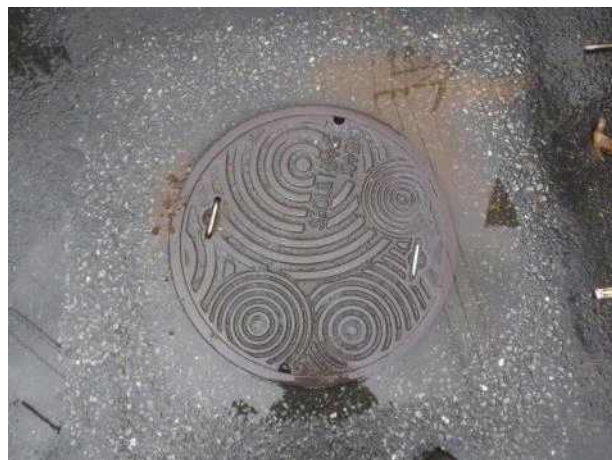
맨홀뚜껑 외부 전경
