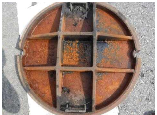
맨홀뚜껑 내부 전경
