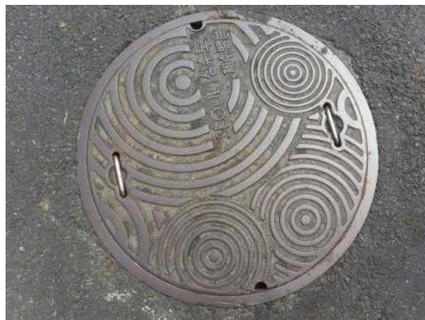
맨홀뚜껑 외부 전경
