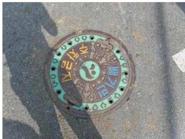
맨홀뚜껑 외부 전경
