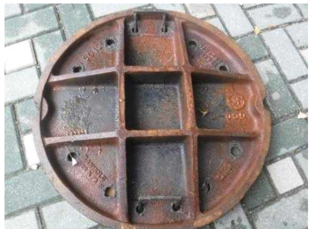
맨홀뚜껑 내부 전경
