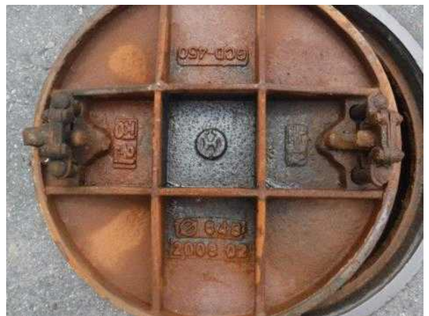
맨홀뚜껑 내부 전경
