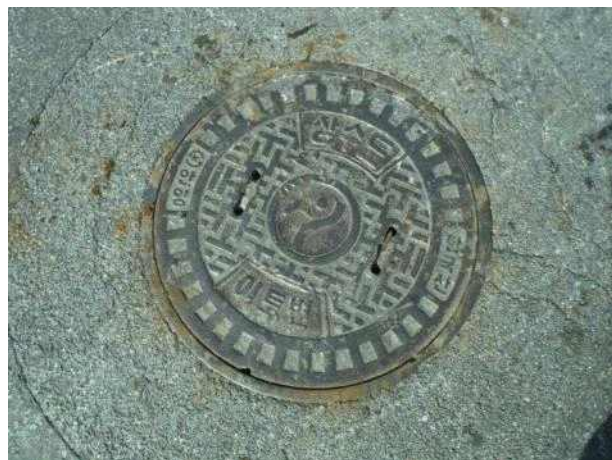
맨홀뚜껑 외부 전경
