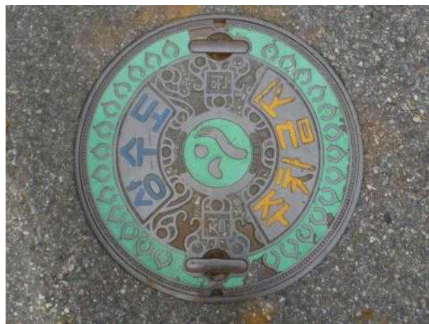
맨홀뚜껑 외부 전경
