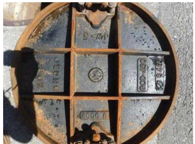
맨홀뚜껑 내부 전경
