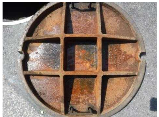
맨홀뚜껑 내부 전경
