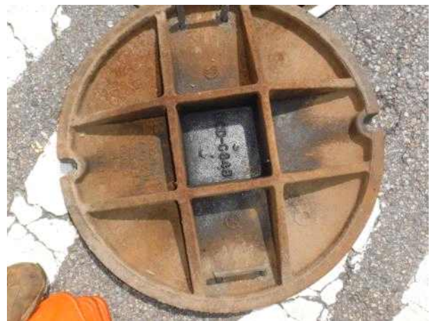
맨홀뚜껑 내부 전경
