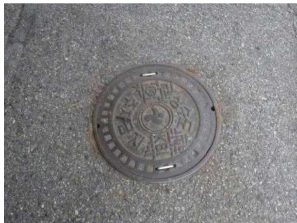
맨홀뚜껑 외부 전경
