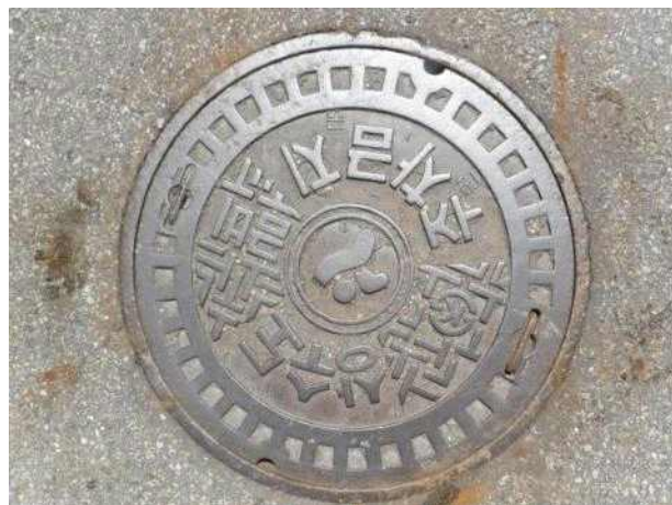
맨홀뚜껑 외부 전경
