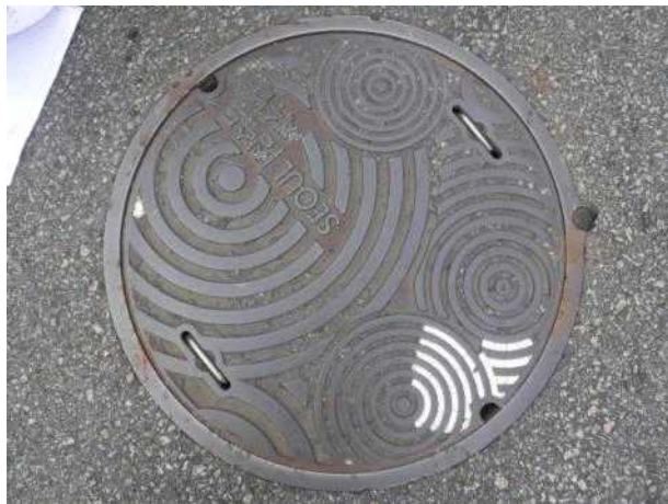
맨홀뚜껑 외부 전경
