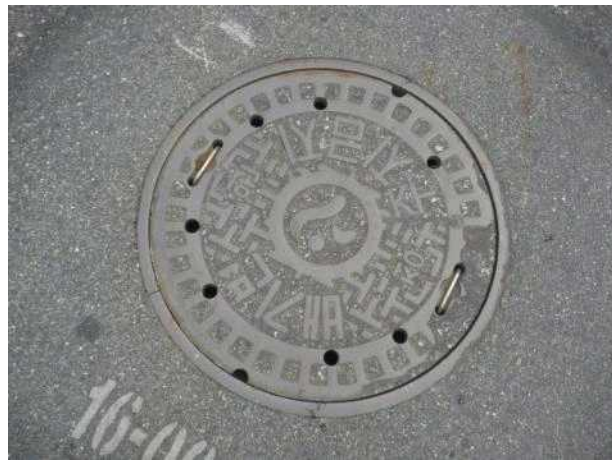
맨홀뚜껑 외부 전경
