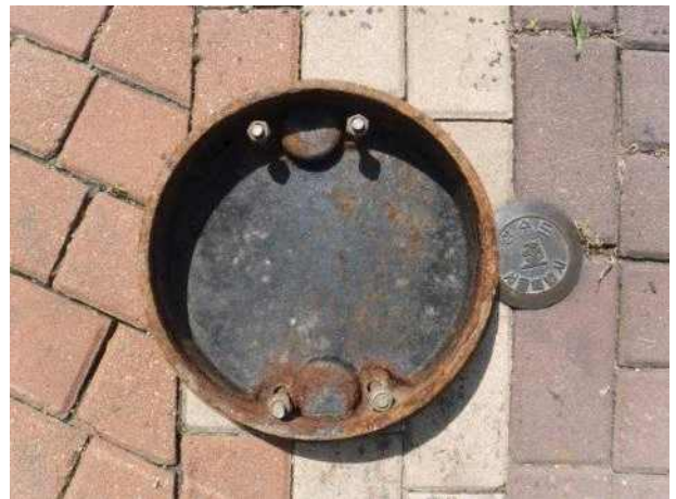
맨홀뚜껑 내부 전경
