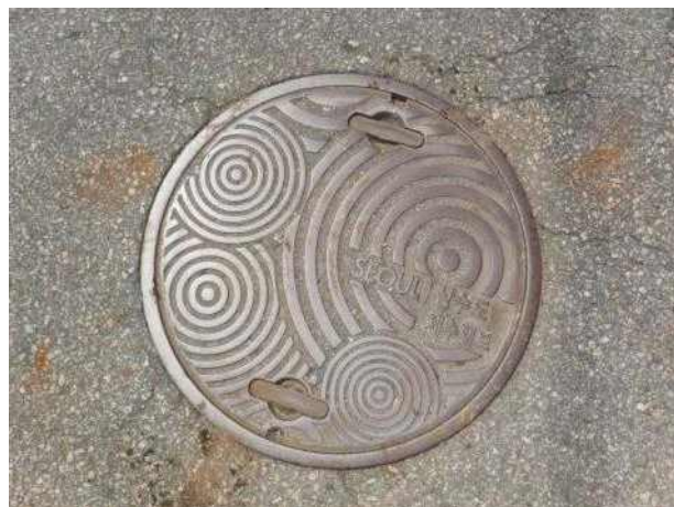
맨홀뚜껑 외부 전경
