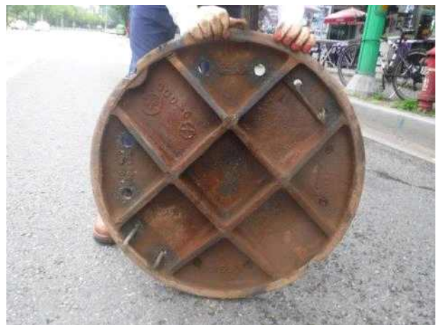
맨홀뚜껑 내부 전경
