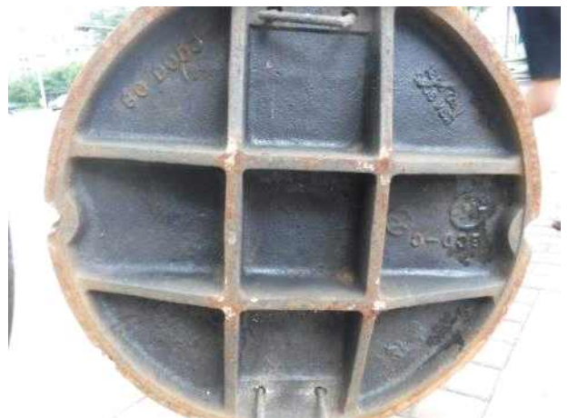
맨홀뚜껑 내부 전경
