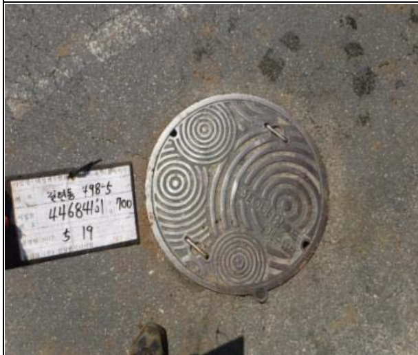
외부 포장 균열
