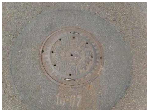
맨홀뚜껑 외부 전경
