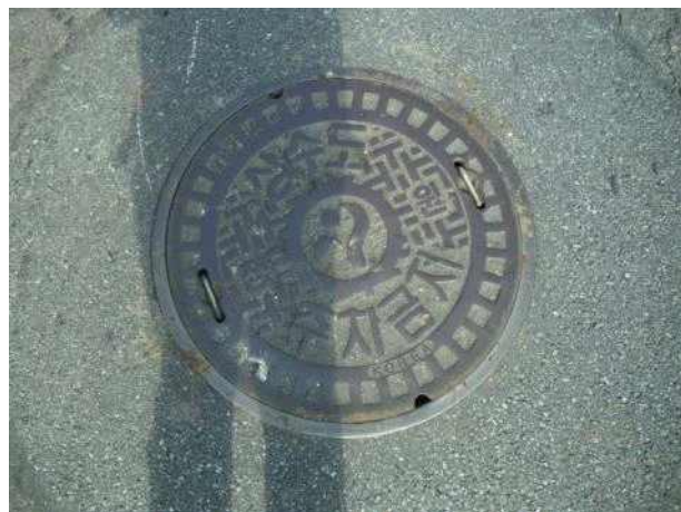
맨홀뚜껑 외부 전경
