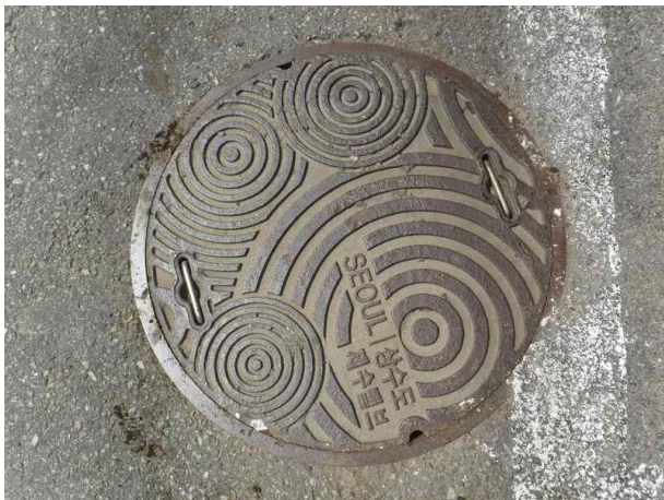
맨홀뚜껑 외부 전경
