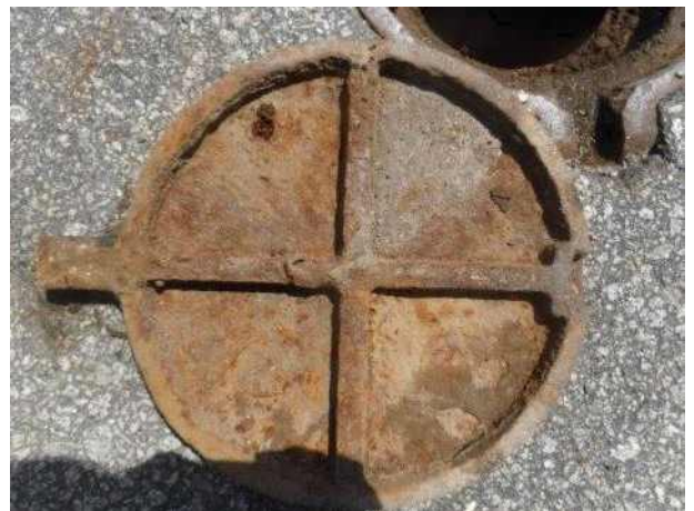
맨홀뚜껑 내부 전경
