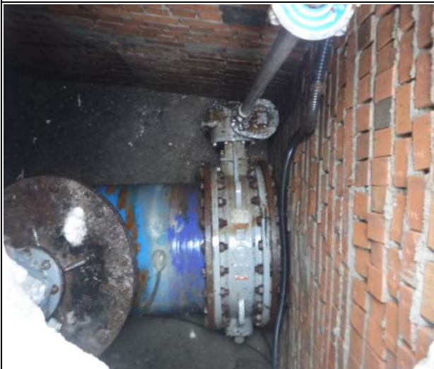
내부 벽체 균열
