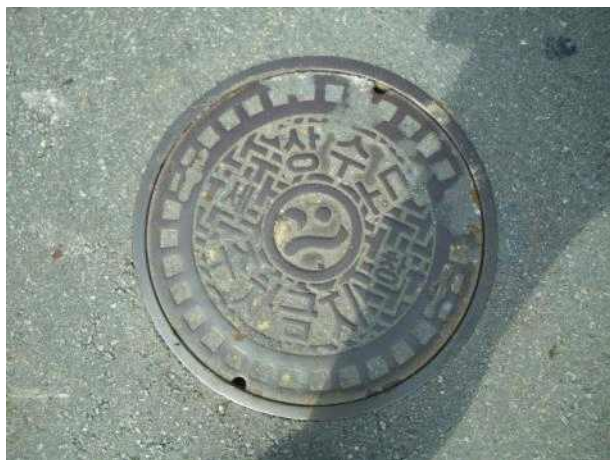
맨홀뚜껑 외부 전경
