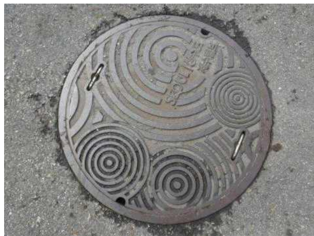
맨홀뚜껑 외부 전경
