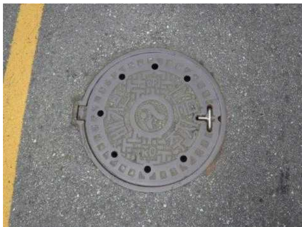
맨홀뚜껑 외부 전경
