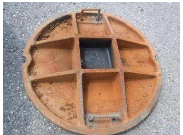
맨홀뚜껑 내부 전경
