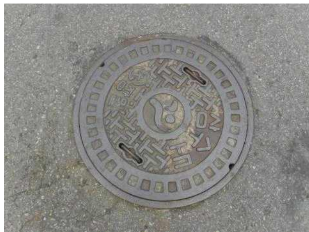
맨홀뚜껑 외부 전경
