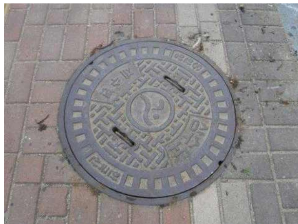
맨홀뚜껑 외부 전경
