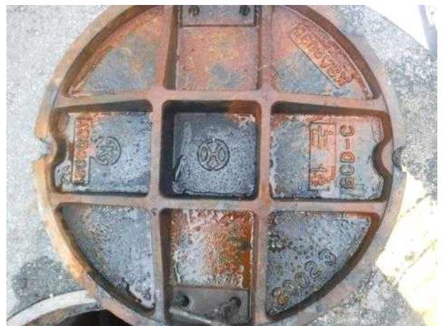
맨홀뚜껑 내부 전경
