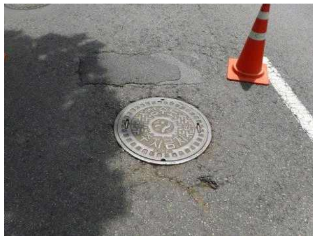
맨홀뚜껑 외부 전경
