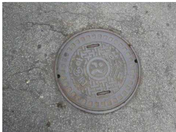
맨홀뚜껑 외부 전경
