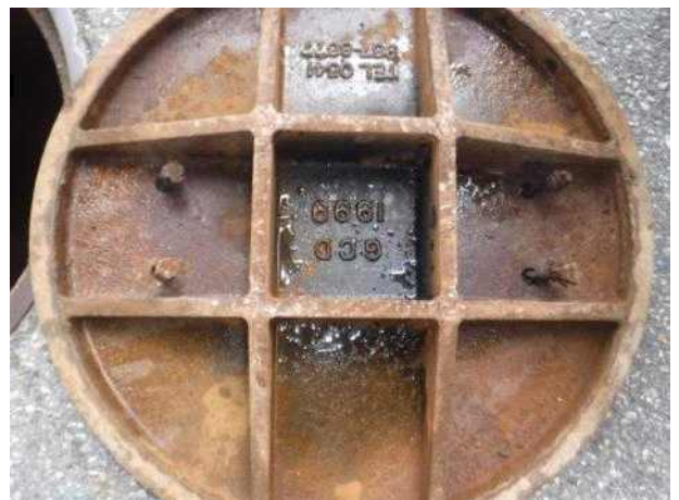
맨홀뚜껑 내부 전경
