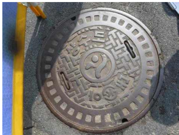
맨홀뚜껑 외부 전경
