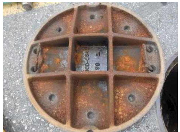
맨홀뚜껑 내부 전경
