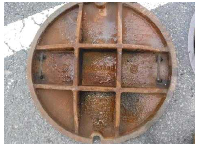
맨홀뚜껑 내부 전경
