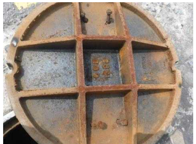
맨홀뚜껑 내부 전경
