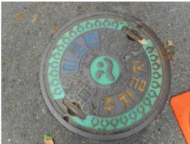
맨홀뚜껑 외부 전경
