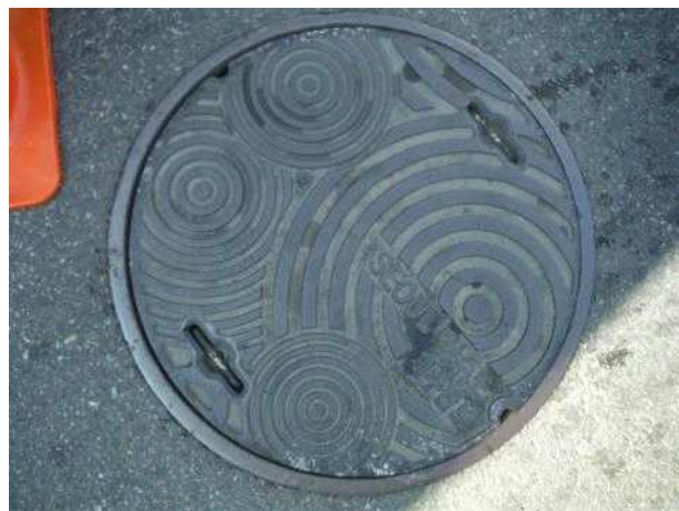
맨홀뚜껑 외부 전경
