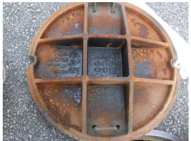
맨홀뚜껑 내부 전경
