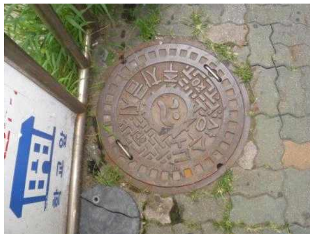
맨홀뚜껑 외부 전경
