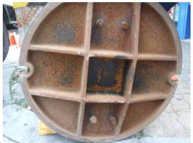
맨홀뚜껑 내부 전경
