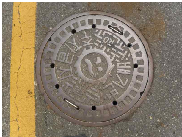
맨홀뚜껑 외부 전경
