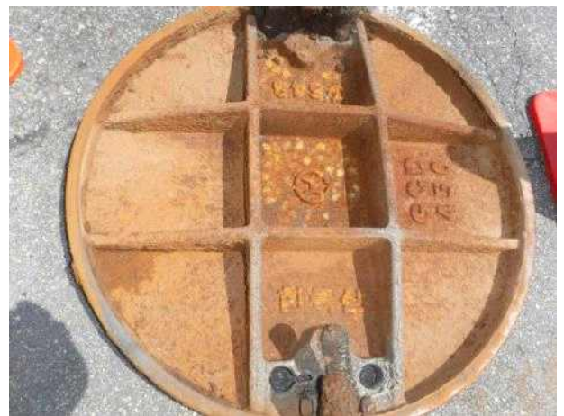
맨홀뚜껑 내부 전경
