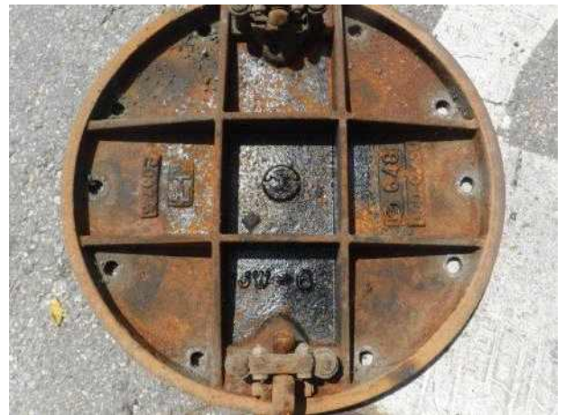
맨홀뚜껑 내부 전경
