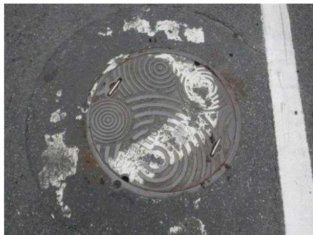
맨홀뚜껑 외부 전경
