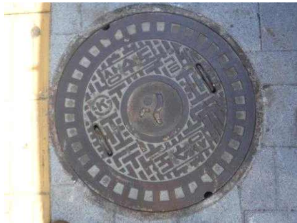
맨홀뚜껑 외부 전경
