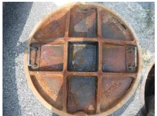
맨홀뚜껑 내부 전경
