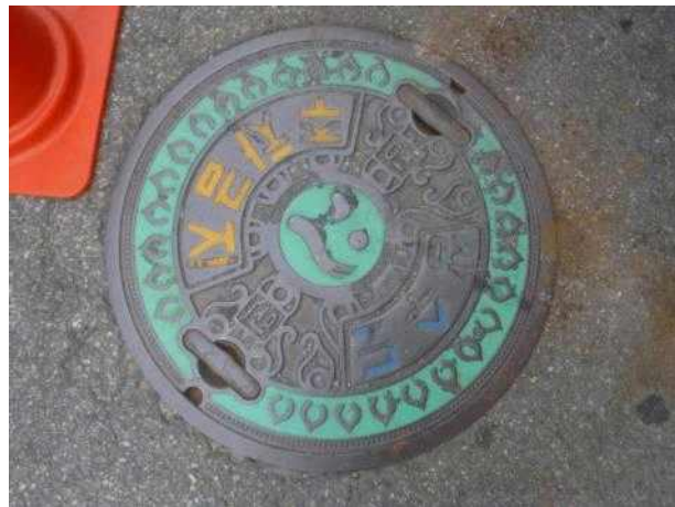
맨홀뚜껑 외부 전경
