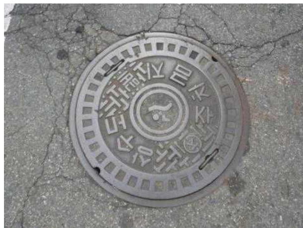
맨홀뚜껑 외부 전경
