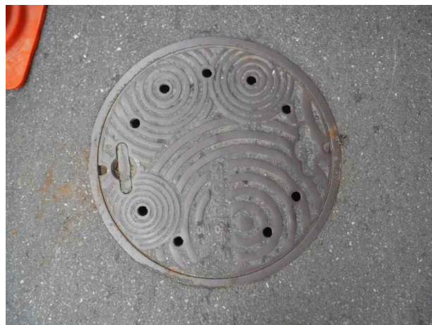
맨홀뚜껑 외부 전경
