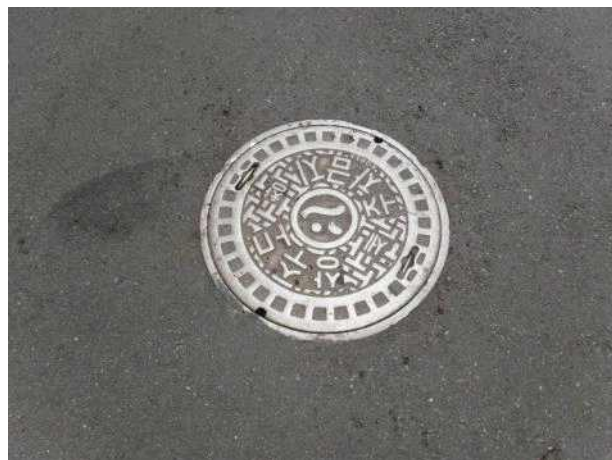
맨홀뚜껑 외부 전경
