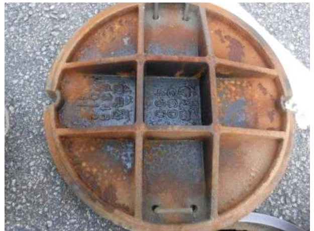
맨홀뚜껑 내부 전경
