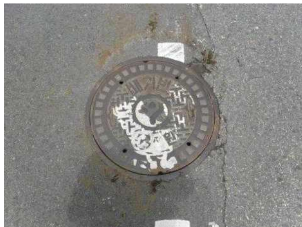
맨홀뚜껑 외부 전경
