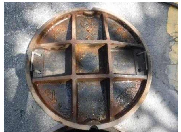
맨홀뚜껑 내부 전경
