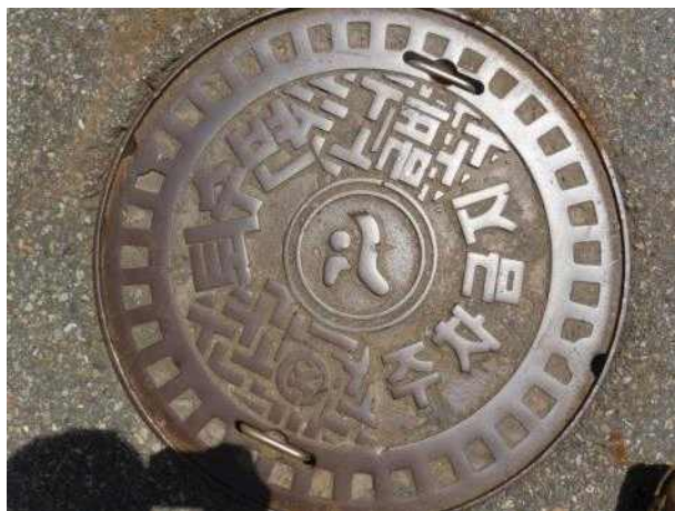
맨홀뚜껑 외부 전경
