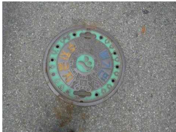
맨홀뚜껑 외부 전경
