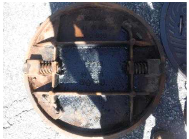
맨홀뚜껑 내부 전경
