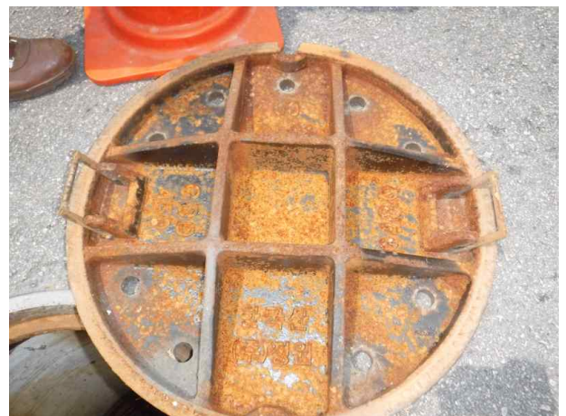
맨홀뚜껑 내부 전경
