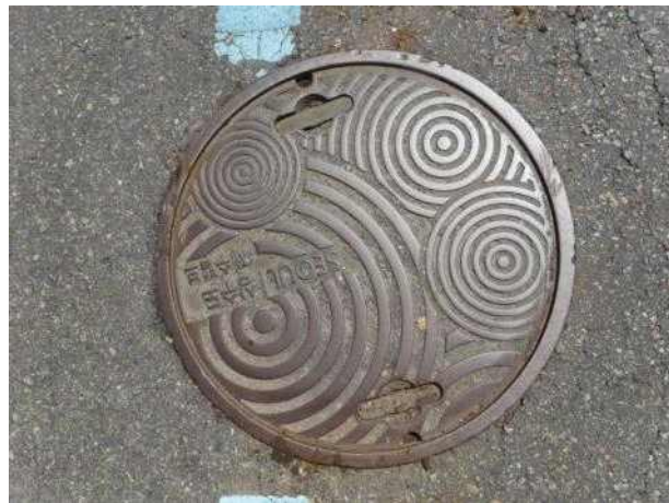
맨홀뚜껑 외부 전경
