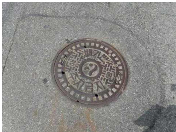
맨홀뚜껑 외부 전경
