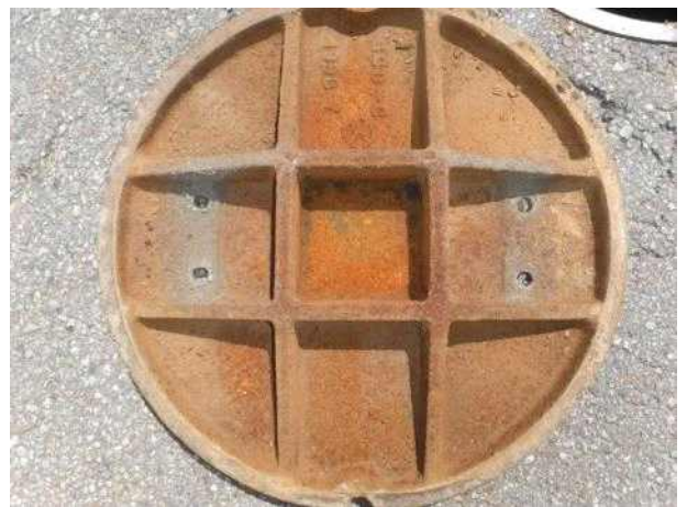
맨홀뚜껑 내부 전경
