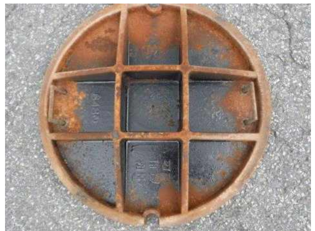
맨홀뚜껑 내부 전경
