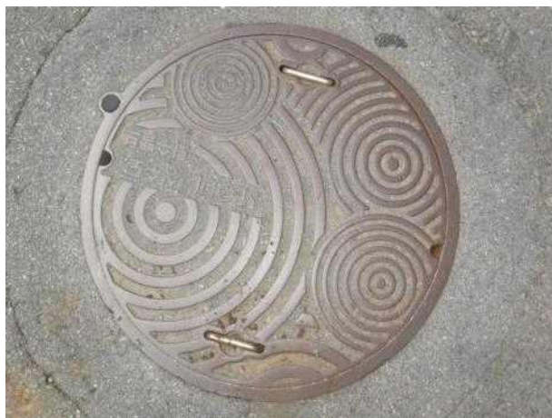
맨홀뚜껑 외부 전경
