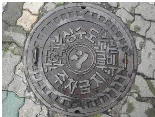
맨홀뚜껑 외부 전경
