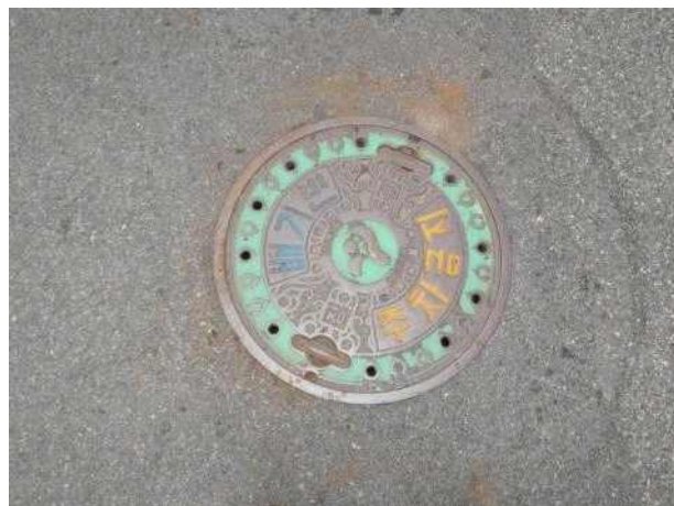
맨홀뚜껑 외부 전경
