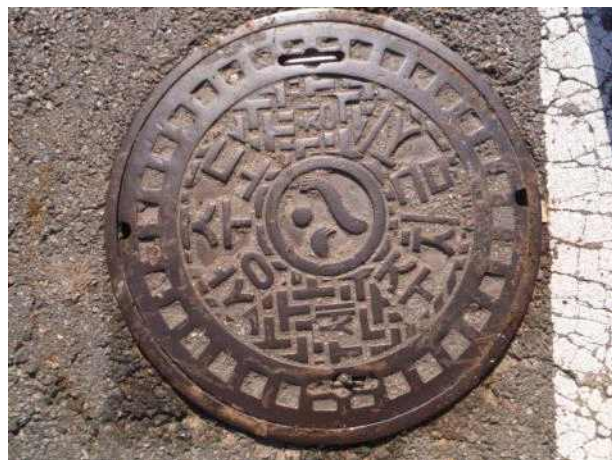
맨홀뚜껑 외부 전경
