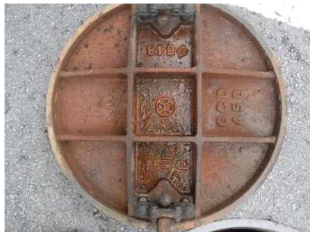
맨홀뚜껑 내부 전경
