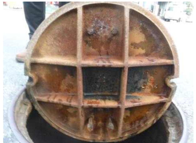
맨홀뚜껑 내부 전경
