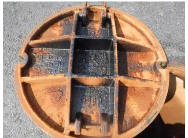
맨홀뚜껑 내부 전경
