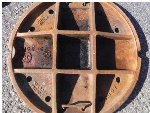
맨홀뚜껑 내부 전경
