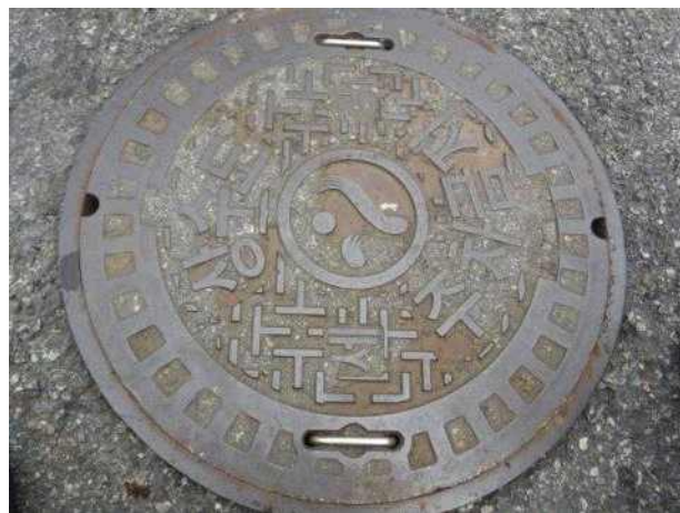
맨홀뚜껑 외부 전경
