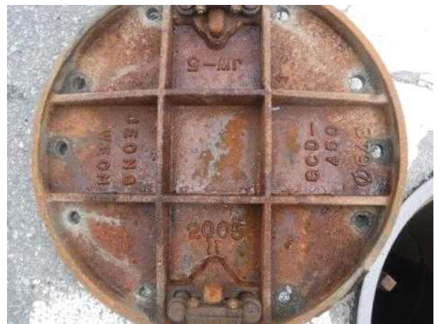
맨홀뚜껑 내부 전경
