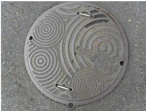
맨홀뚜껑 외부 전경
