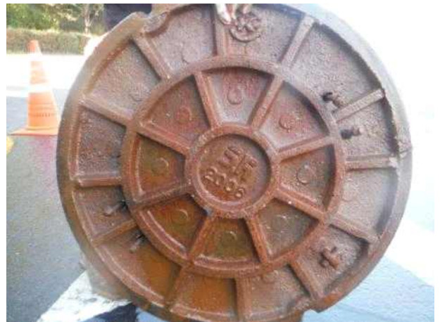
맨홀뚜껑 내부 전경
