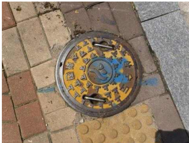
맨홀뚜껑 외부 전경
