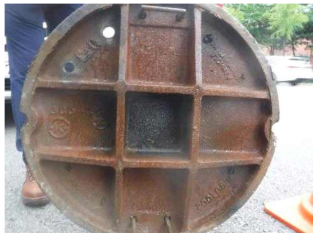
맨홀뚜껑 내부 전경
