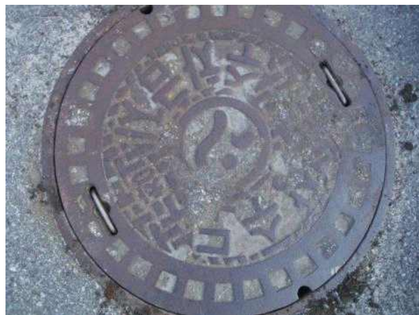
맨홀뚜껑 외부 전경
