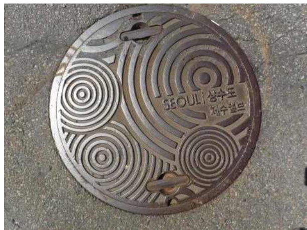
맨홀뚜껑 외부 전경
