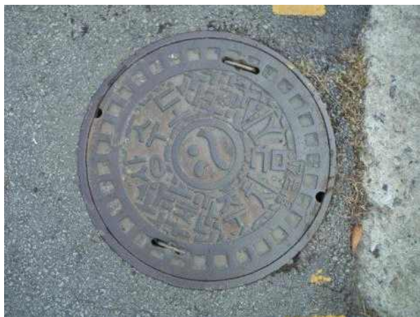
맨홀뚜껑 외부 전경
