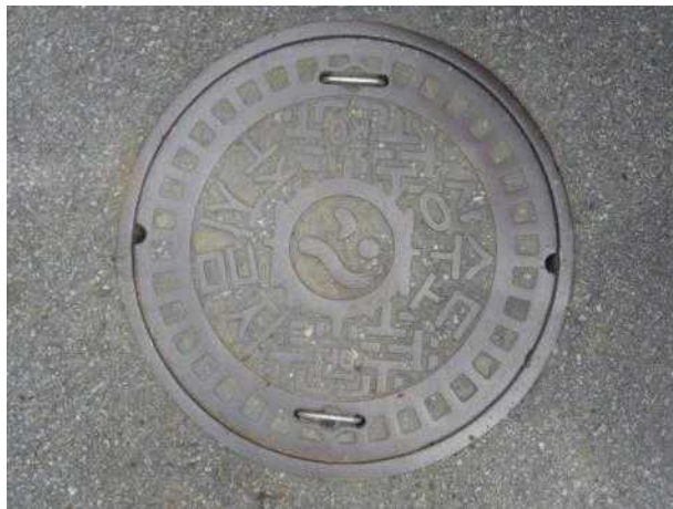
맨홀뚜껑 외부 전경
