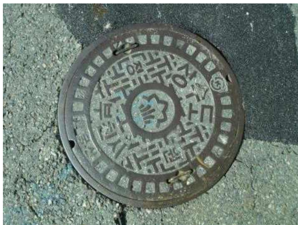
맨홀뚜껑 외부 전경
