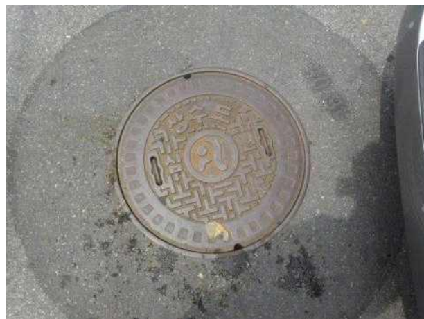
맨홀뚜껑 외부 전경
