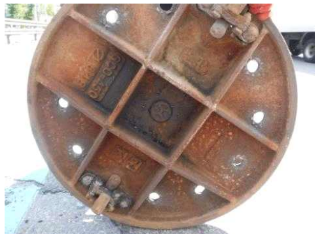
맨홀뚜껑 내부 전경
