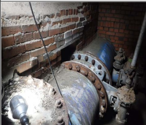
내부 벽체 균열
