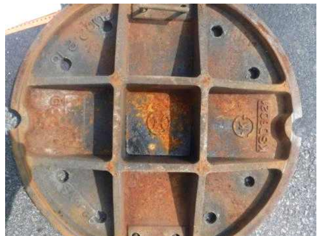
맨홀뚜껑 내부 전경
