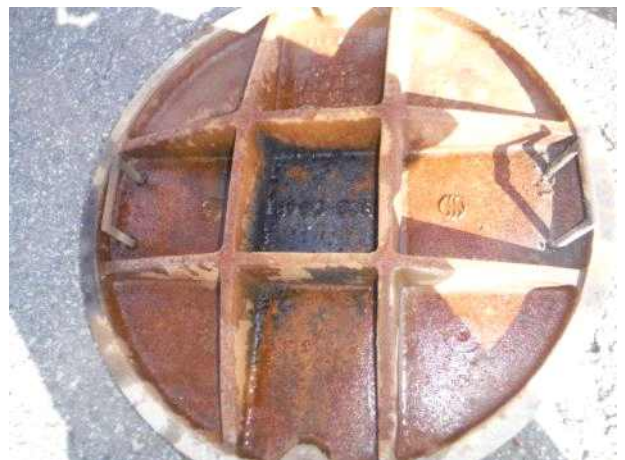
맨홀뚜껑 내부 전경
