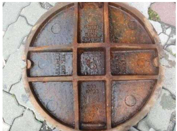
맨홀뚜껑 내부 전경
