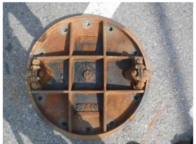
맨홀뚜껑 내부 전경
