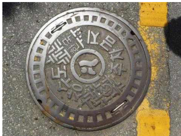
맨홀뚜껑 외부 전경
