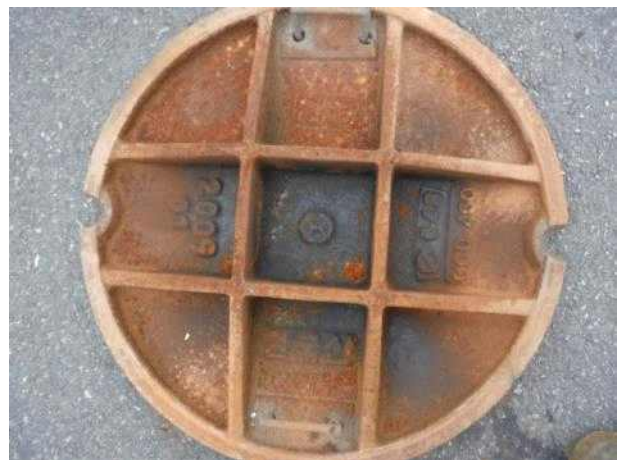
맨홀뚜껑 내부 전경
