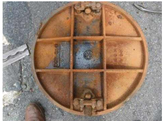
맨홀뚜껑 내부 전경
