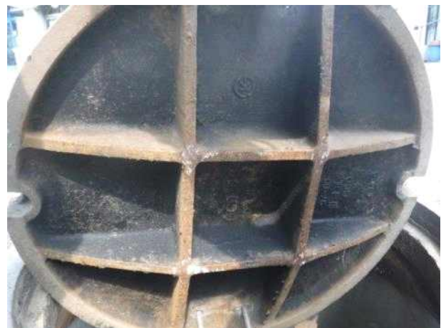
맨홀뚜껑 내부 전경
