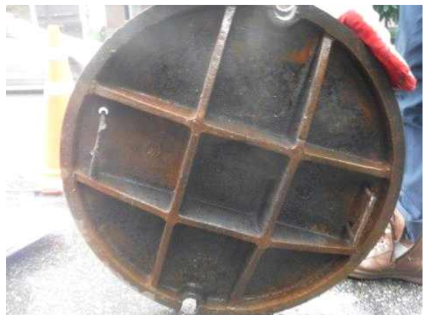
맨홀뚜껑 내부 전경
