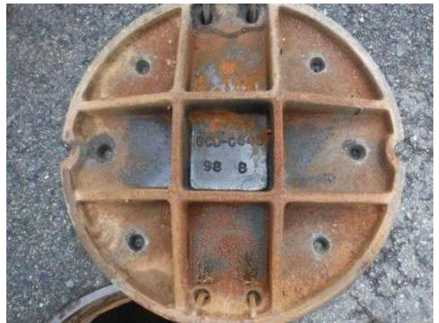
맨홀뚜껑 내부 전경
