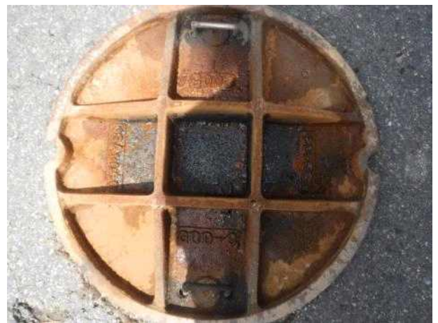
맨홀뚜껑 내부 전경
