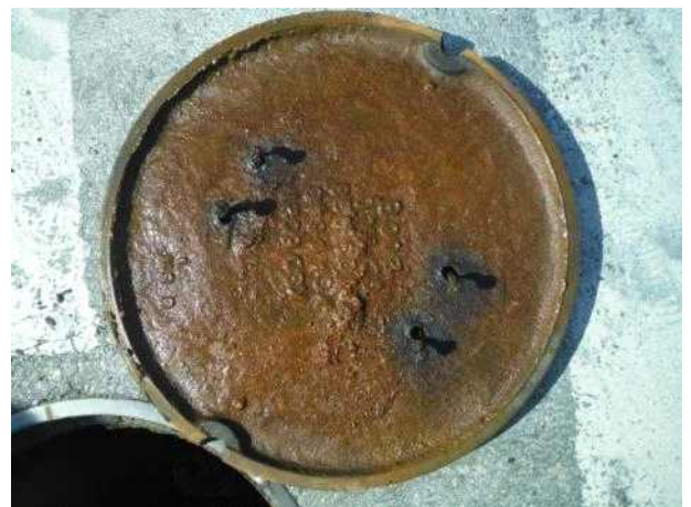
맨홀뚜껑 내부 전경
