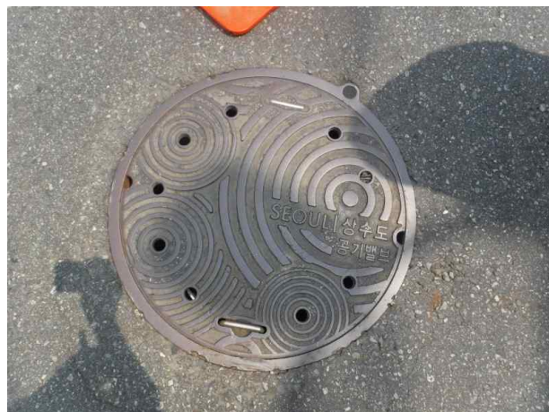
맨홀뚜껑 외부 전경
