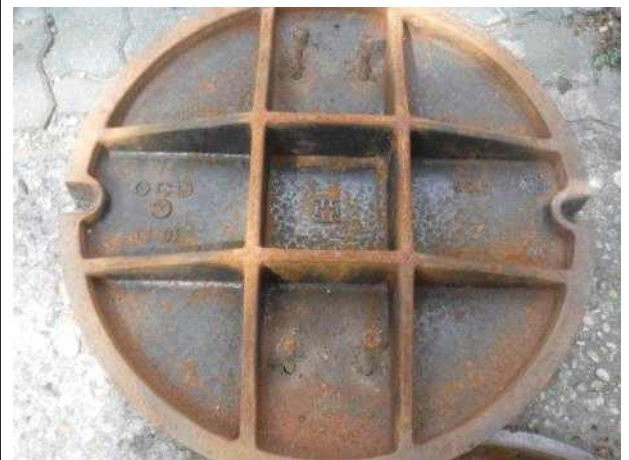
맨홀뚜껑 내부 전경
