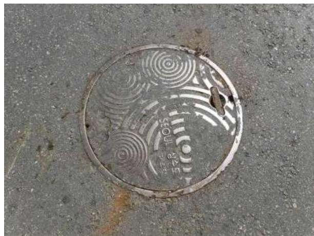
맨홀뚜껑 외부 전경
