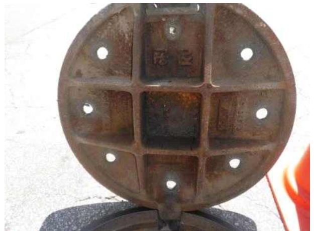
맨홀뚜껑 내부 전경
