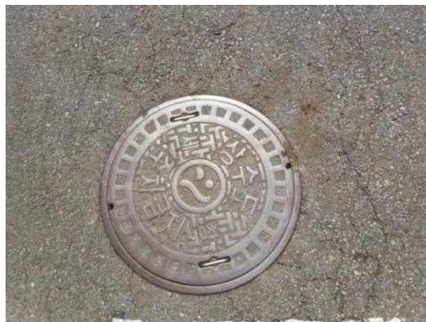
맨홀뚜껑 외부 전경
