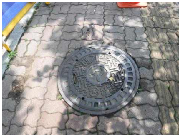
맨홀뚜껑 외부 전경
