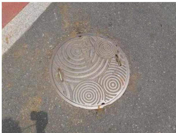
맨홀뚜껑 외부 전경
