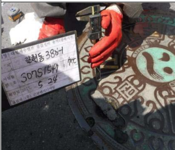
마모 상태 점검
