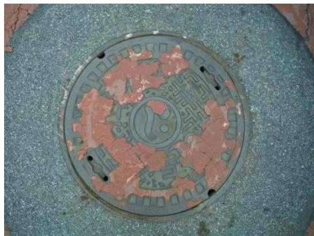
맨홀뚜껑 외부 전경
