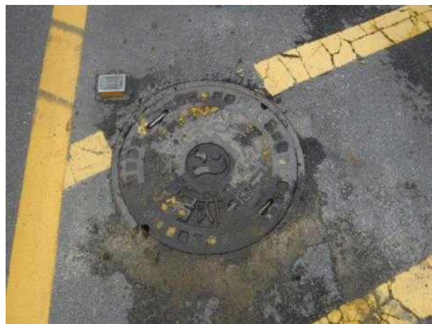
맨홀뚜껑 외부 전경
