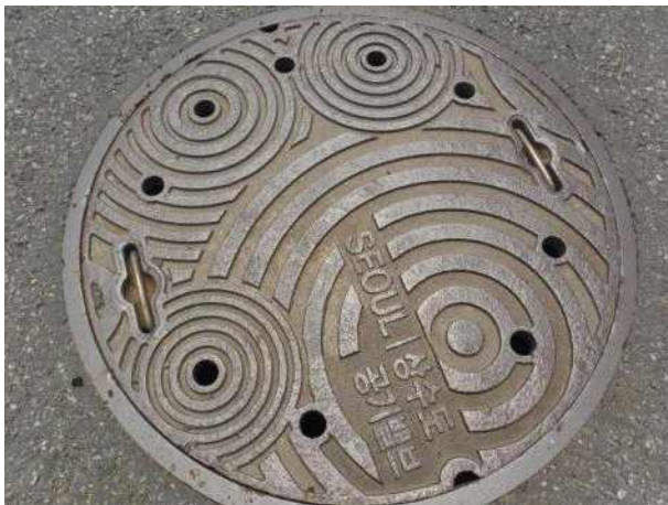
맨홀뚜껑 외부 전경
