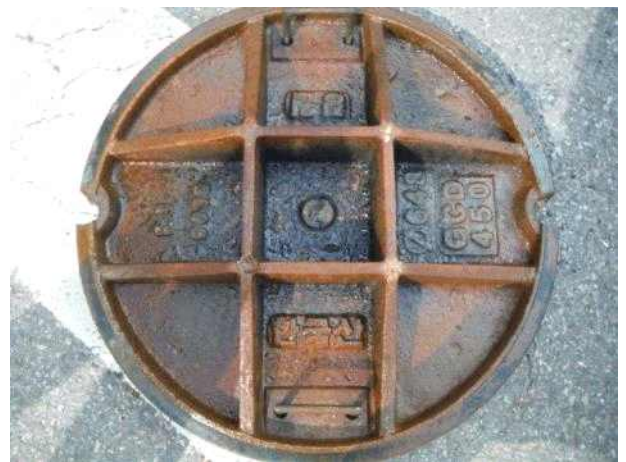
맨홀뚜껑 내부 전경
