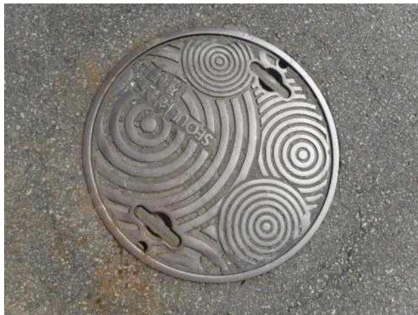
맨홀뚜껑 외부 전경
