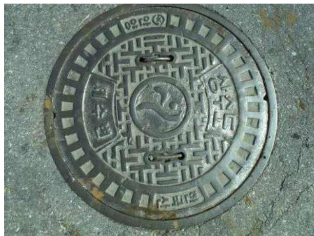
맨홀뚜껑 외부 전경
