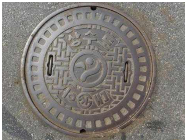
맨홀뚜껑 외부 전경
