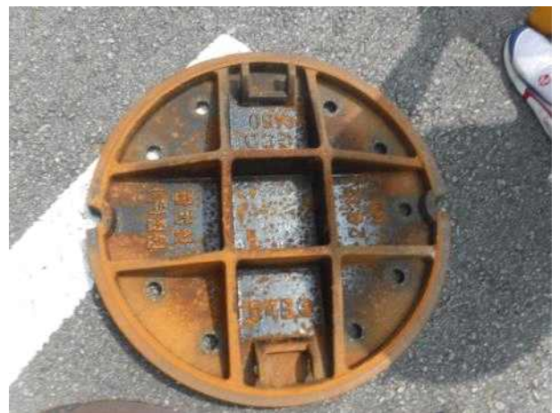
맨홀뚜껑 내부 전경
