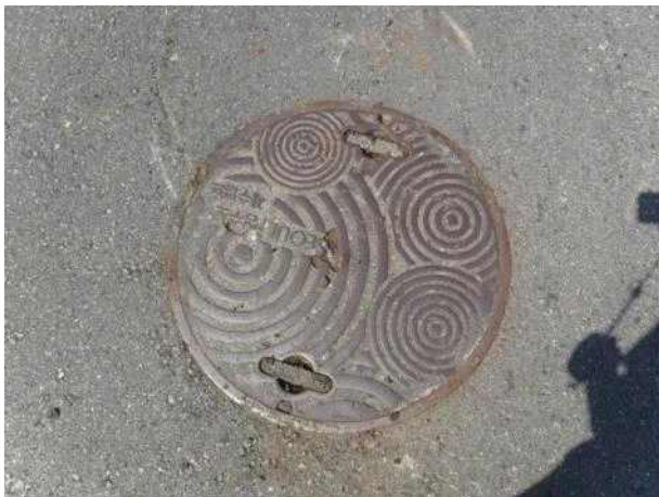
맨홀뚜껑 외부 전경
