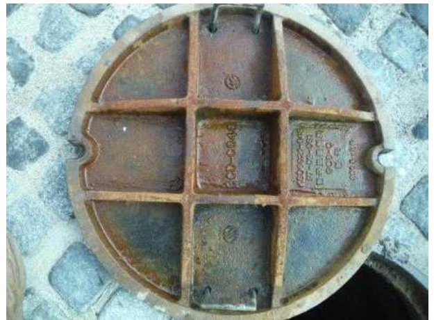
맨홀뚜껑 내부 전경
