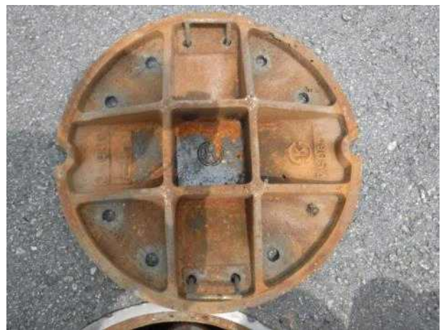
맨홀뚜껑 내부 전경
