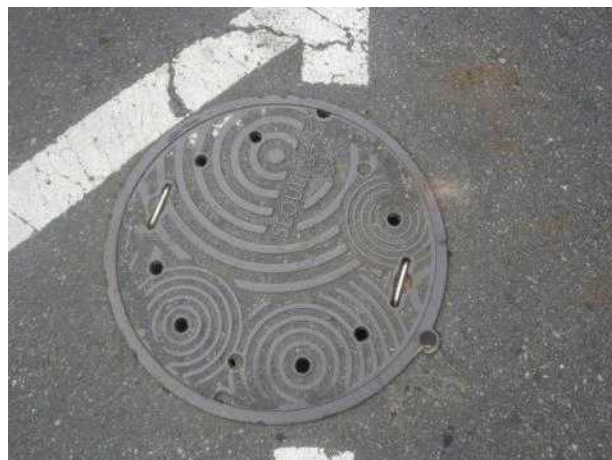
맨홀뚜껑 외부 전경
