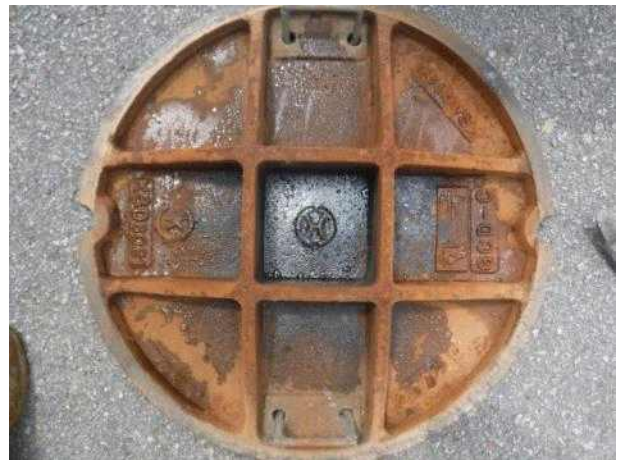
맨홀뚜껑 내부 전경
