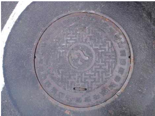
맨홀뚜껑 외부 전경
