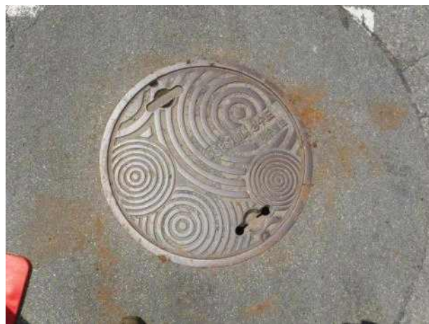
맨홀뚜껑 외부 전경
