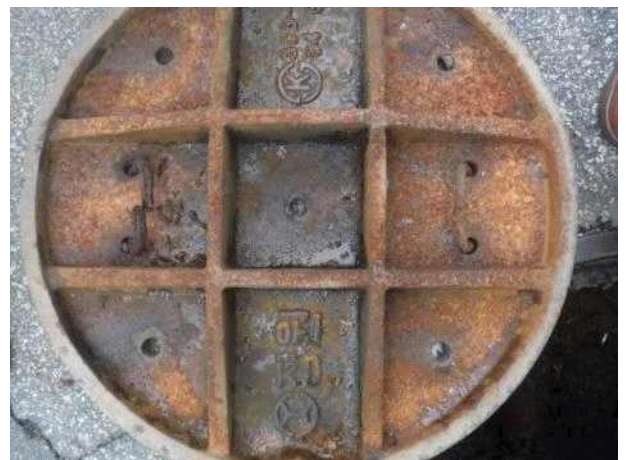
맨홀뚜껑 내부 전경
