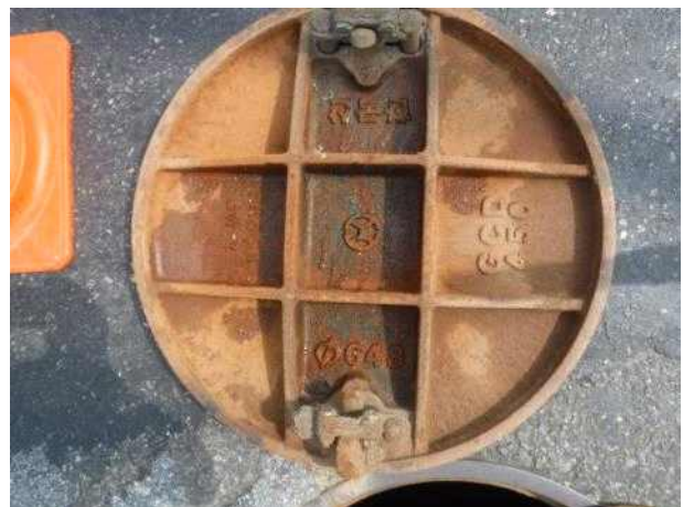
맨홀뚜껑 내부 전경
