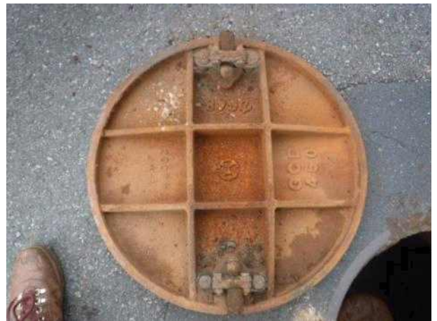
맨홀뚜껑 내부 전경
