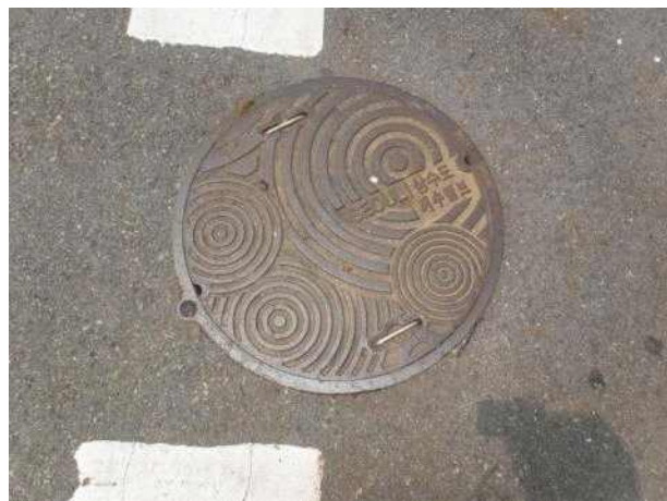
맨홀뚜껑 외부 전경
