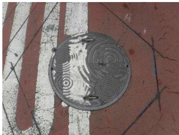
맨홀뚜껑 외부 전경
