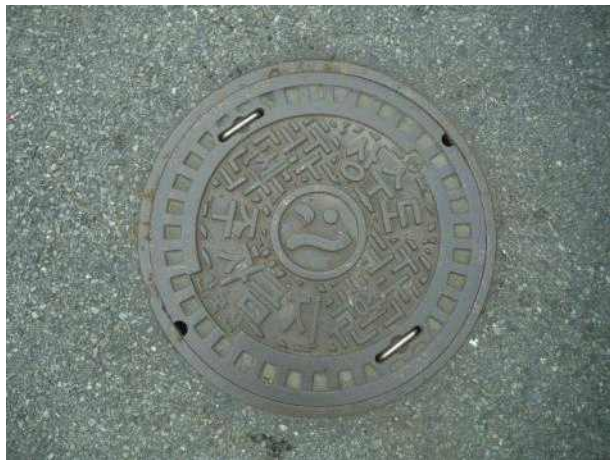
맨홀뚜껑 외부 전경
