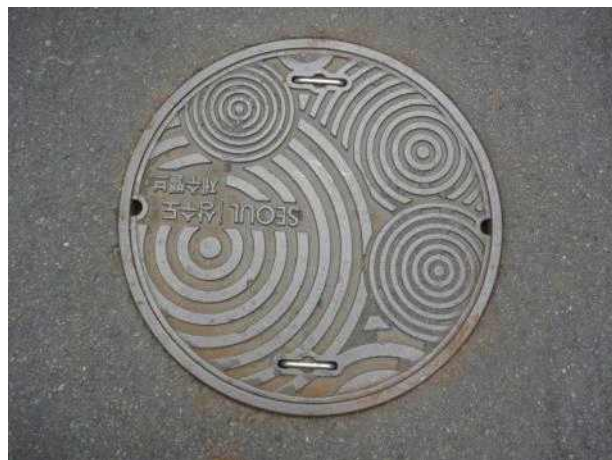
맨홀뚜껑 외부 전경
