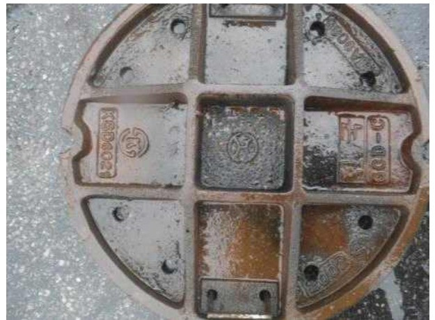
맨홀뚜껑 내부 전경
