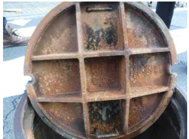
맨홀뚜껑 내부 전경
