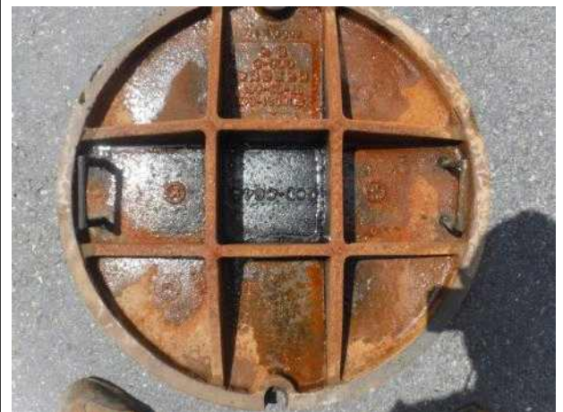
맨홀뚜껑 내부 전경
