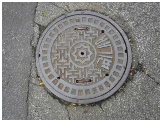
맨홀뚜껑 외부 전경
