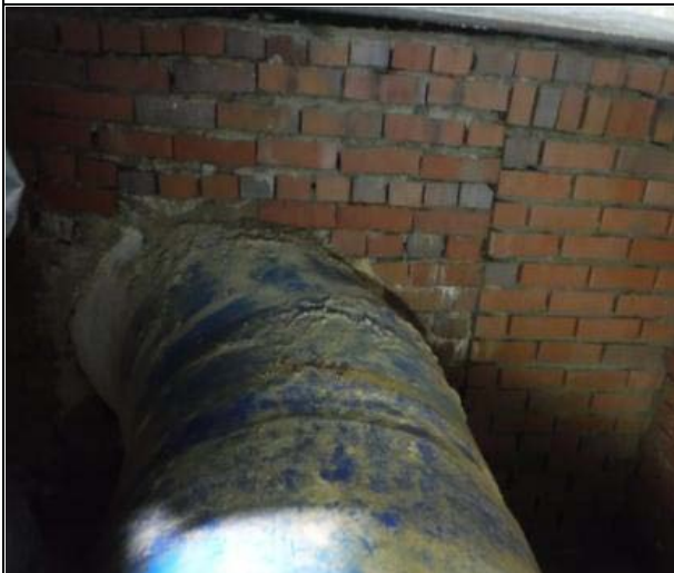
내부 벽체 균열
