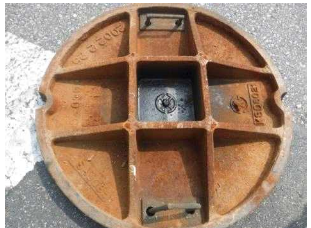
맨홀뚜껑 내부 전경
