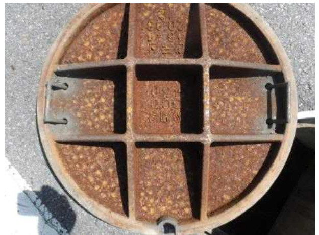
맨홀뚜껑 내부 전경
