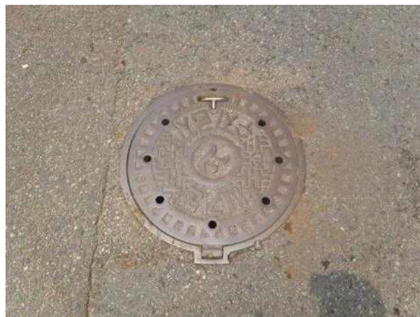
맨홀뚜껑 외부 전경
