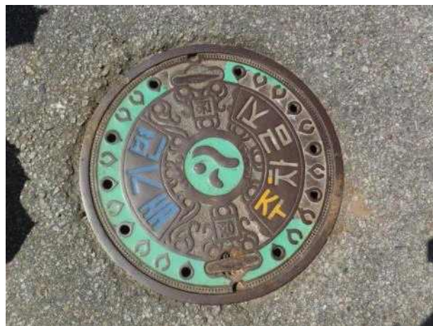
맨홀뚜껑 외부 전경
