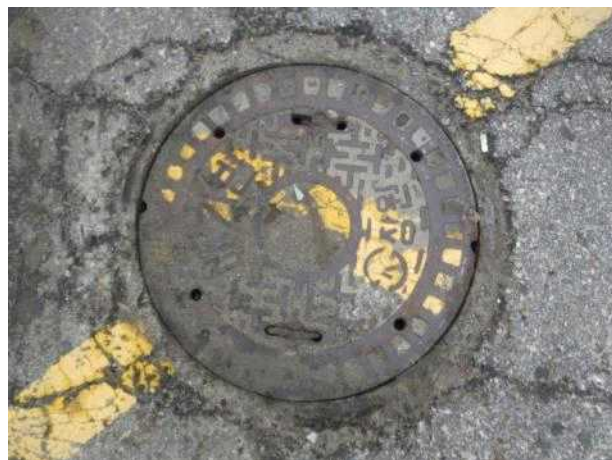
맨홀뚜껑 외부 전경
