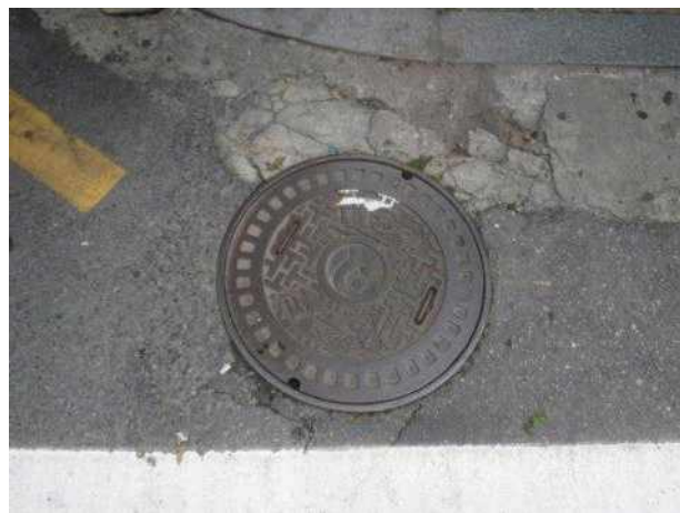
맨홀뚜껑 외부 전경
