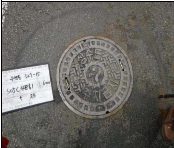
외부 포장 균열
