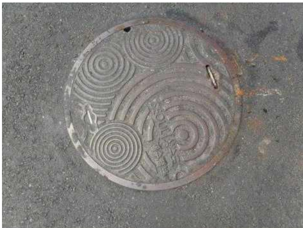
맨홀뚜껑 외부 전경
