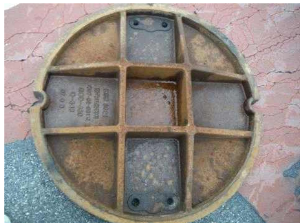
맨홀뚜껑 내부 전경
