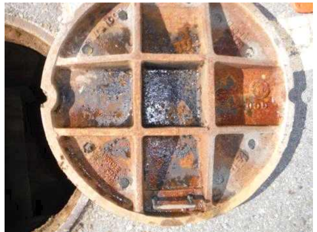
맨홀뚜껑 내부 전경
