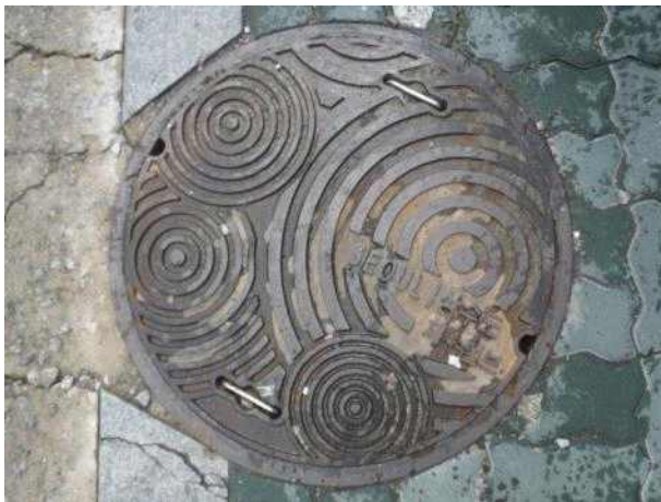
맨홀뚜껑 외부 전경
