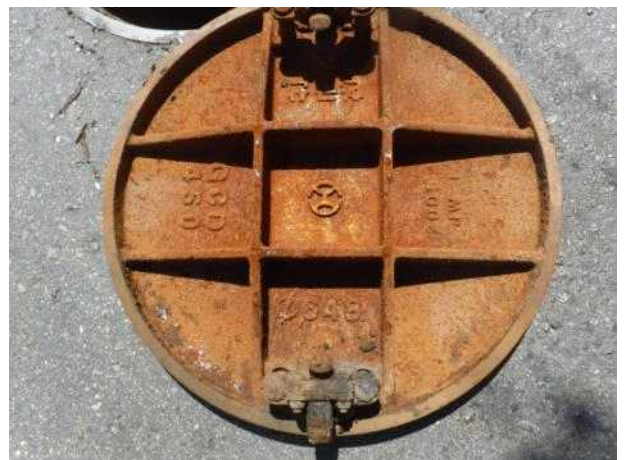
맨홀뚜껑 내부 전경
