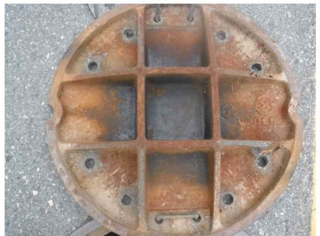
맨홀뚜껑 내부 전경
