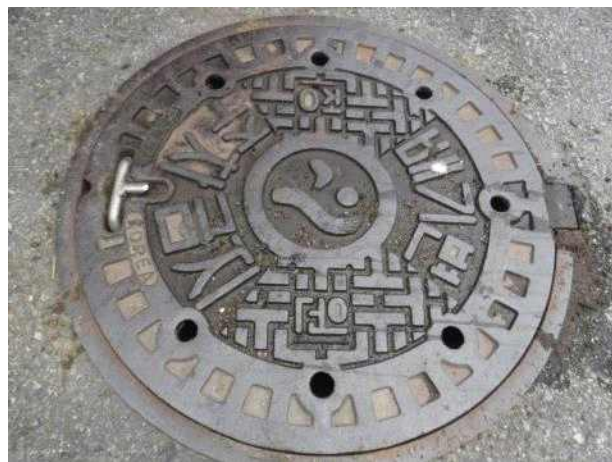
맨홀뚜껑 외부 전경
