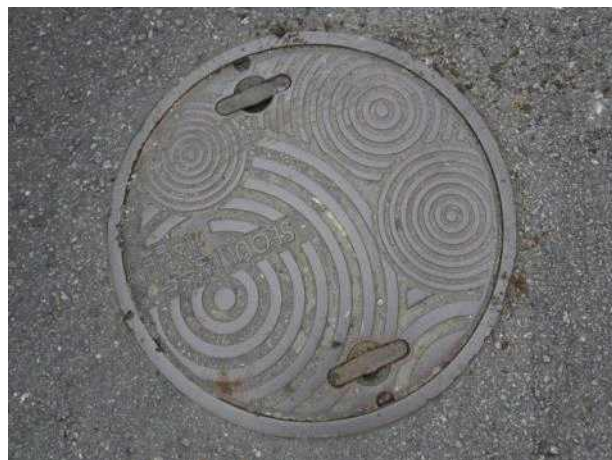
맨홀뚜껑 외부 전경
