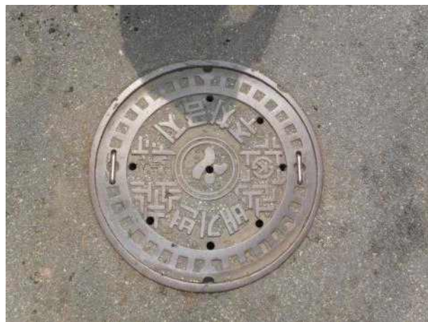
맨홀뚜껑 외부 전경
