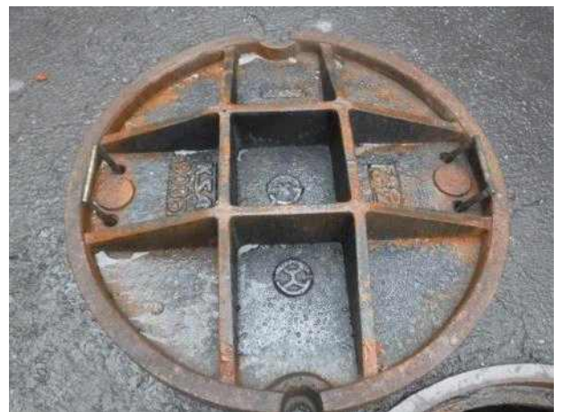
맨홀뚜껑 내부 전경
