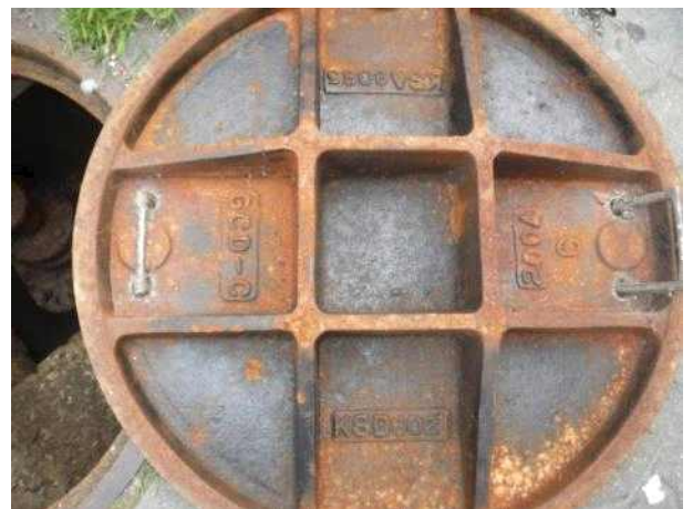
맨홀뚜껑 내부 전경
