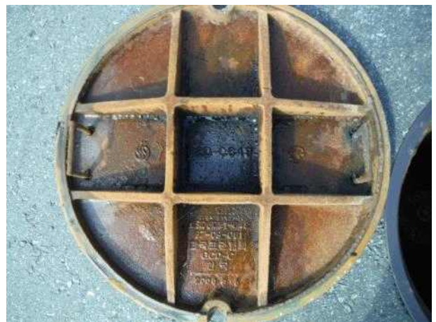
맨홀뚜껑 내부 전경
