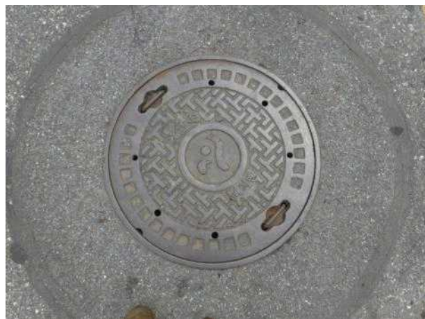
맨홀뚜껑 외부 전경
