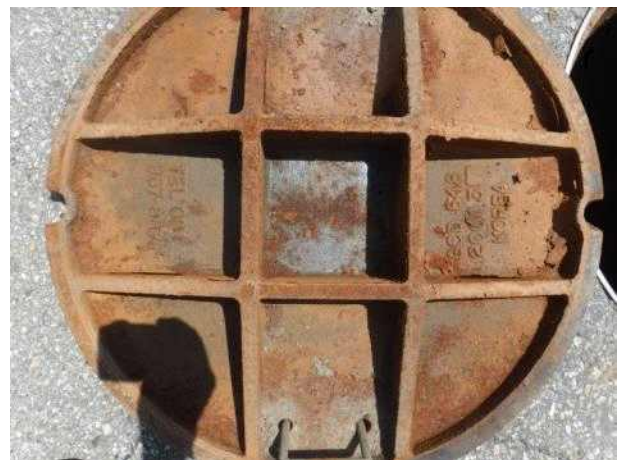
맨홀뚜껑 내부 전경
