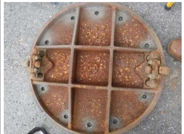
맨홀뚜껑 내부 전경
