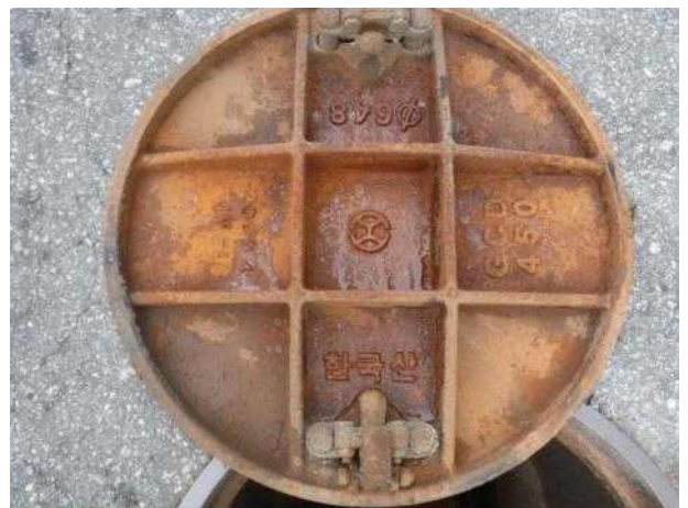
맨홀뚜껑 내부 전경
