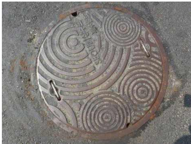
맨홀뚜껑 외부 전경
