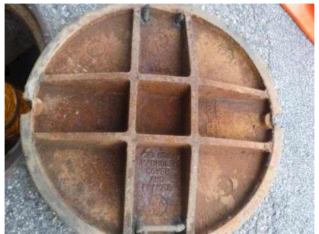
맨홀뚜껑 내부 전경
