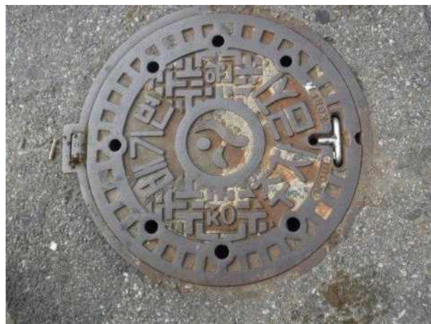
맨홀뚜껑 외부 전경
