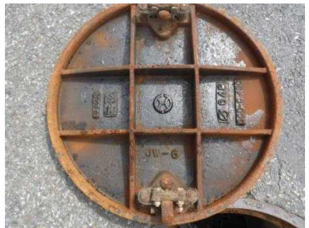
맨홀뚜껑 내부 전경
