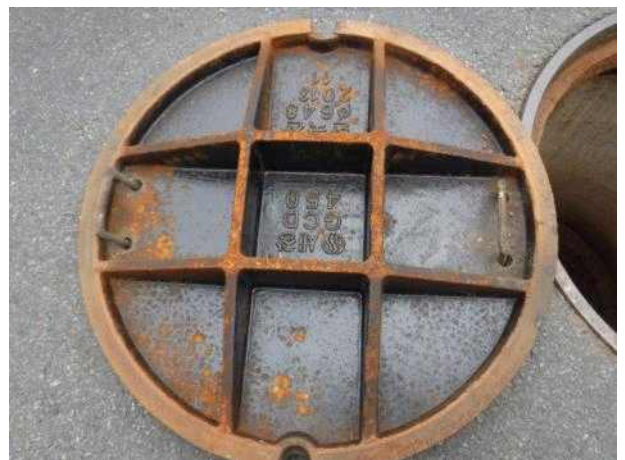
맨홀뚜껑 내부 전경
