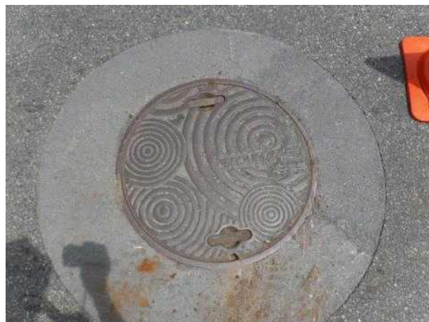
맨홀뚜껑 외부 전경
