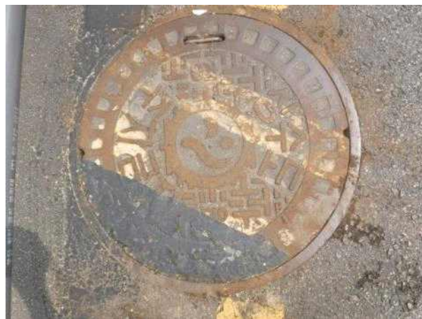
맨홀뚜껑 외부 전경
