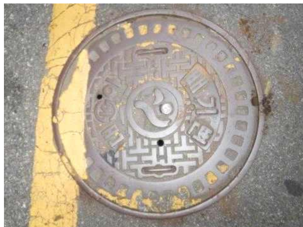
맨홀뚜껑 외부 전경
