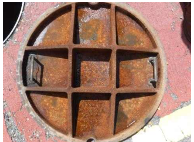
맨홀뚜껑 내부 전경
