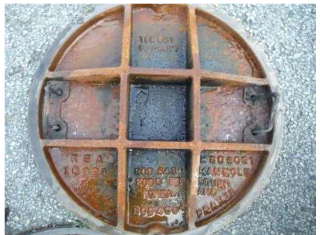
맨홀뚜껑 내부 전경
