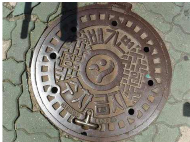
맨홀뚜껑 외부 전경
