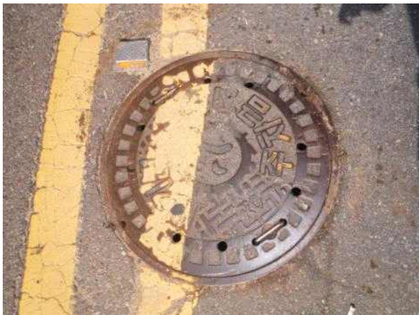
맨홀뚜껑 외부 전경
