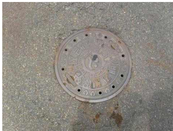
맨홀뚜껑 외부 전경
