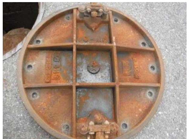
맨홀뚜껑 내부 전경
