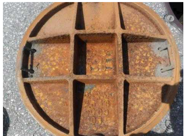
맨홀뚜껑 내부 전경
