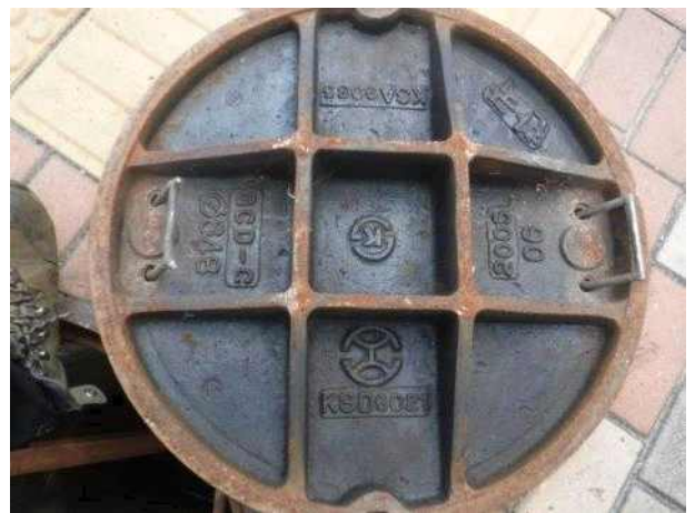
맨홀뚜껑 내부 전경
