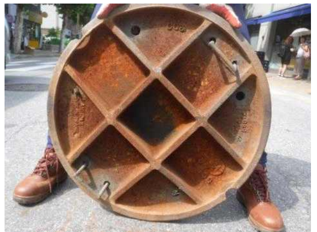
맨홀뚜껑 내부 전경
