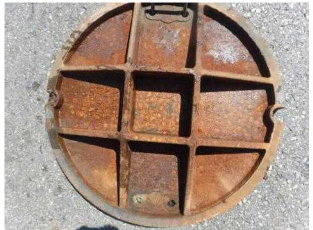
맨홀뚜껑 내부 전경
