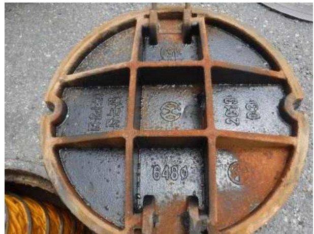
맨홀뚜껑 내부 전경
