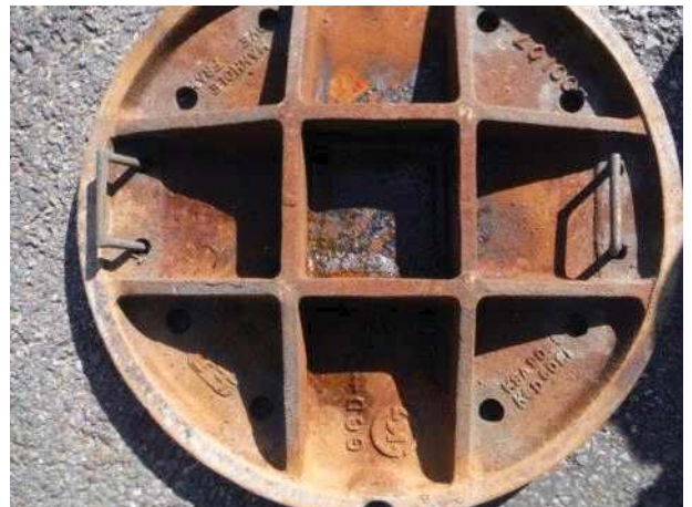
맨홀뚜껑 내부 전경
