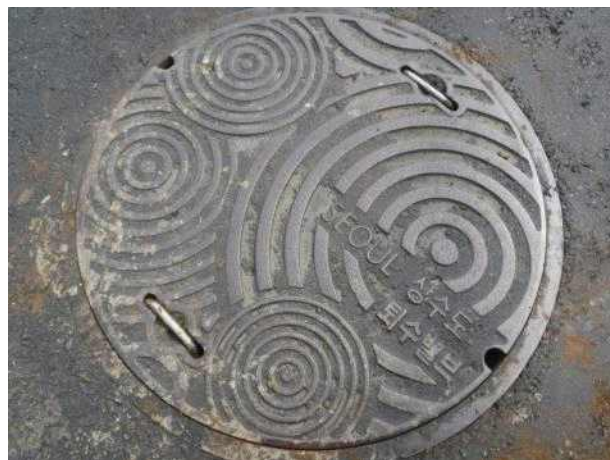
맨홀뚜껑 외부 전경
