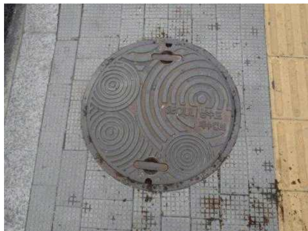
맨홀뚜껑 외부 전경
