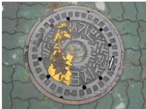
맨홀뚜껑 외부 전경
