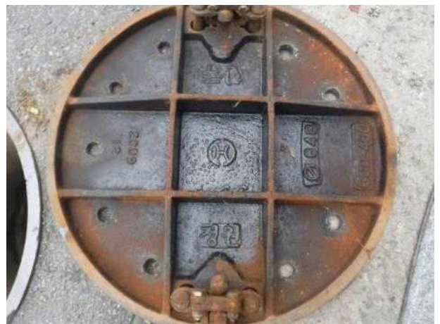
맨홀뚜껑 내부 전경
