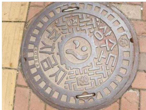
맨홀뚜껑 외부 전경
