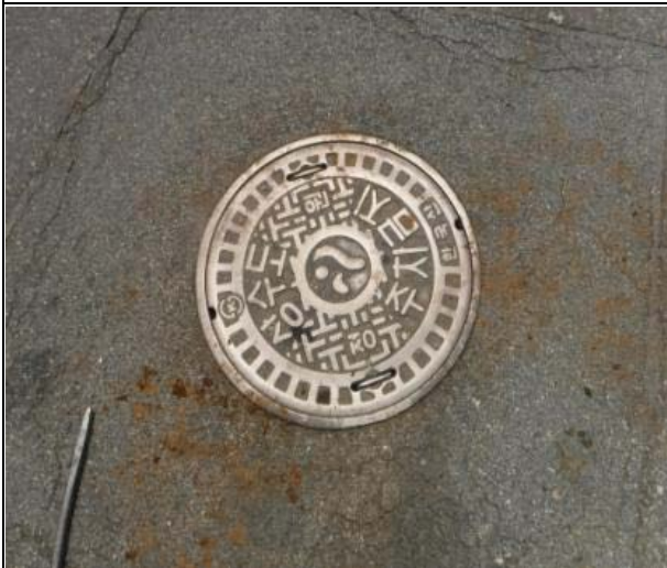
외부 포장 균열
