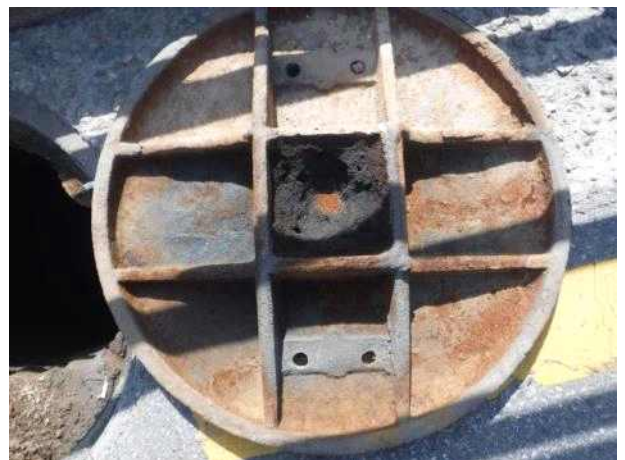
맨홀뚜껑 내부 전경
