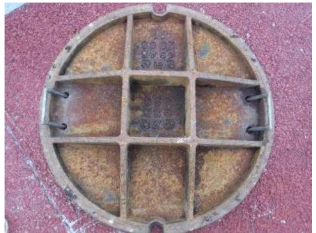
맨홀뚜껑 내부 전경
