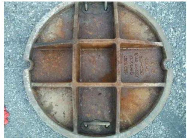
맨홀뚜껑 내부 전경
