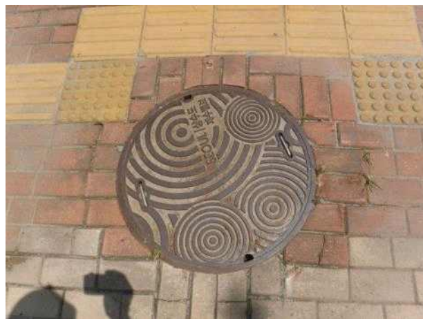
맨홀뚜껑 외부 전경
