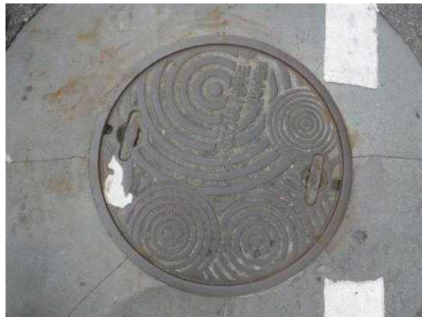
맨홀뚜껑 외부 전경
