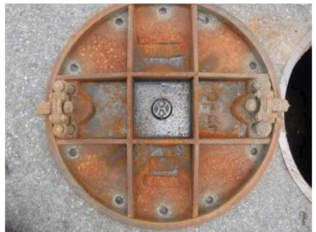
맨홀뚜껑 내부 전경
