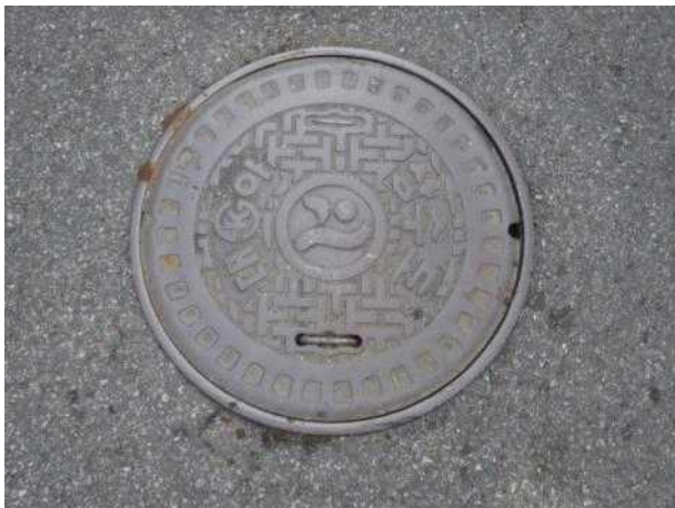
맨홀뚜껑 외부 전경
