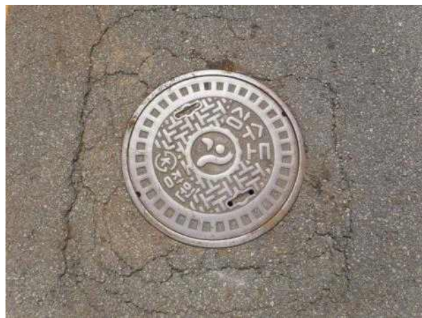
맨홀뚜껑 외부 전경
