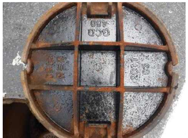
맨홀뚜껑 내부 전경
