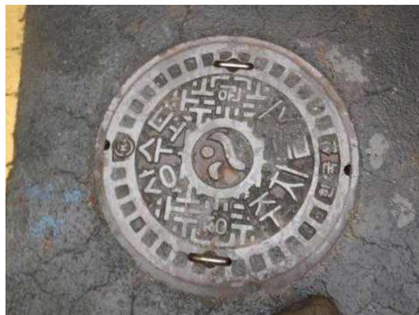
맨홀뚜껑 외부 전경
