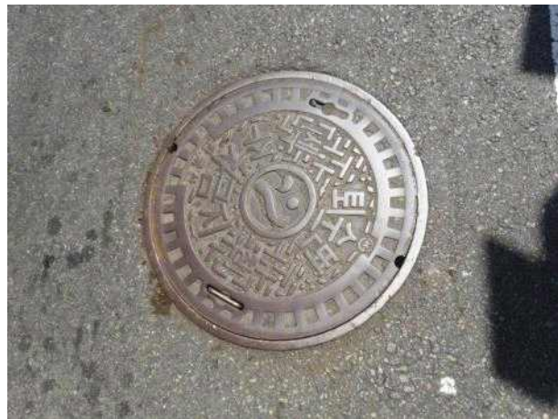
맨홀뚜껑 외부 전경
